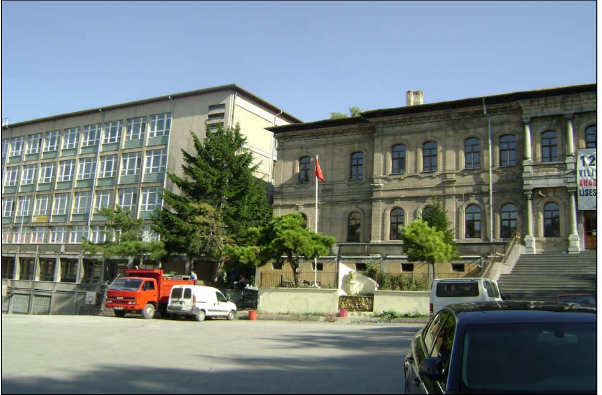
Kütahya Lisesi Taş Mektep ve Ek Bina (2010)
