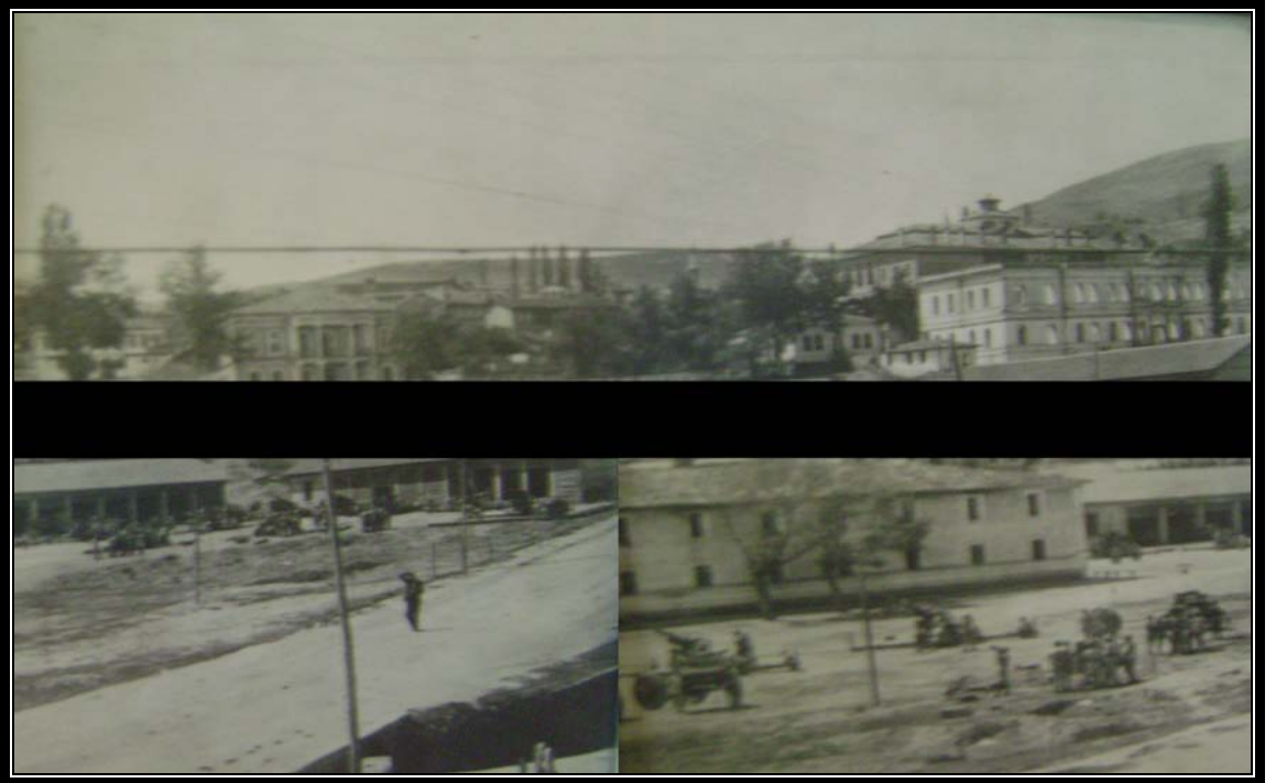
Ek-B.2: Ali Paşa Mahallesi (Lisenin Ön Cephesi) (1920)
