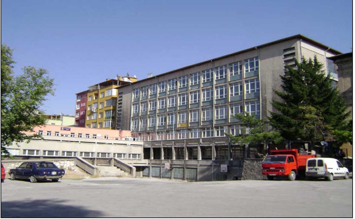
Kütahya Lisesi Ek Bina ve C Blok (2010)
