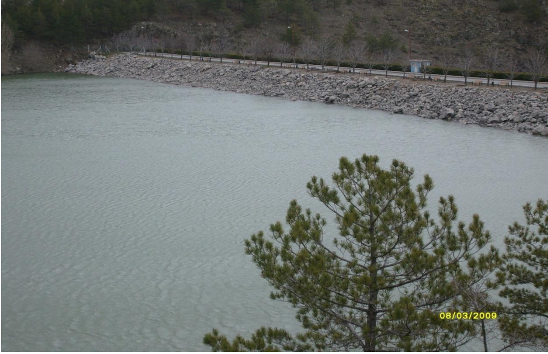
Foto 5. Çubuk II Barajı'nın Kuzeyden Görünümü.
