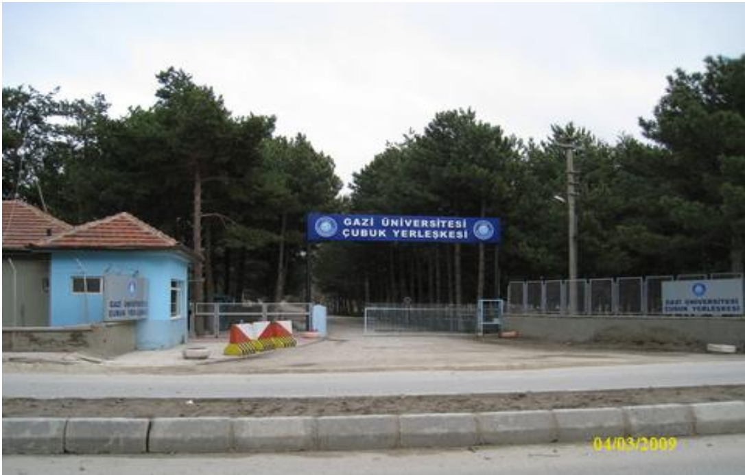
Foto 10. Gazi Üniversitesi Meslek Yüksek Okulu Çubuk Yerleşkesi (Çubuk).
