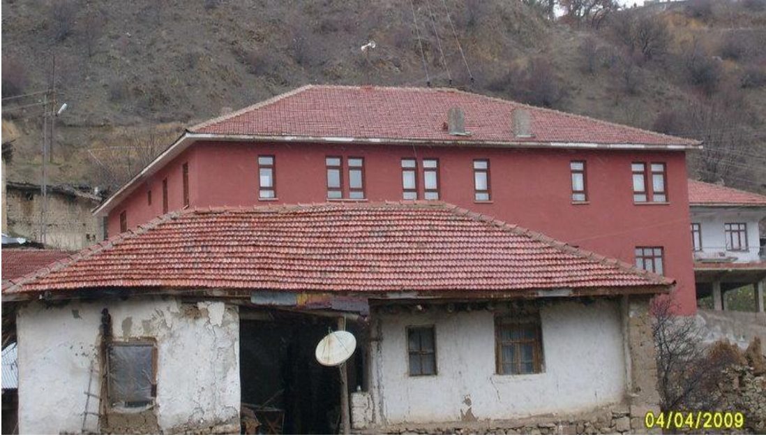
Foto 17. Kırsal Kesimde Kerpiç Yapı Malzemesinin Kullanıldığı Meskenlere Örnek (Dalyasan Köyü).
