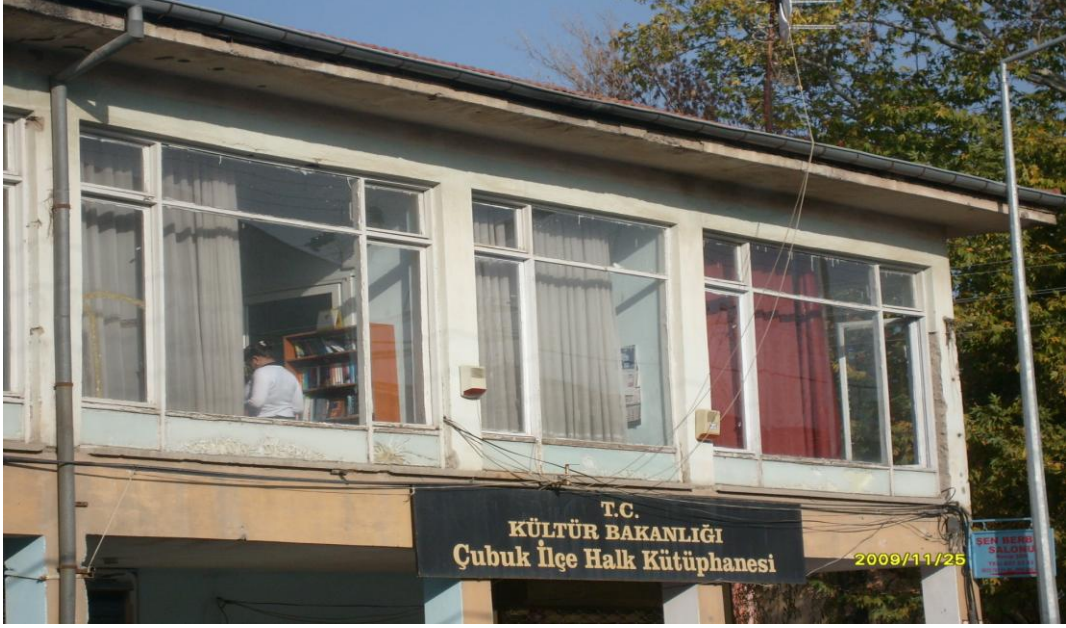
Foto 15. Çubuk İlçe Kütüphanesi.
