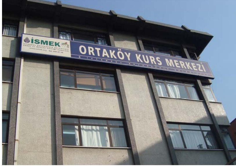
Fotoğraf-1: Beşiktaş- Ortaköy Kurs Merkezi Binası
