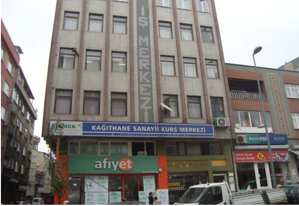
Fotoğraf-7: Kâğıthane – Sanayi Kurs Merkezi Binası
