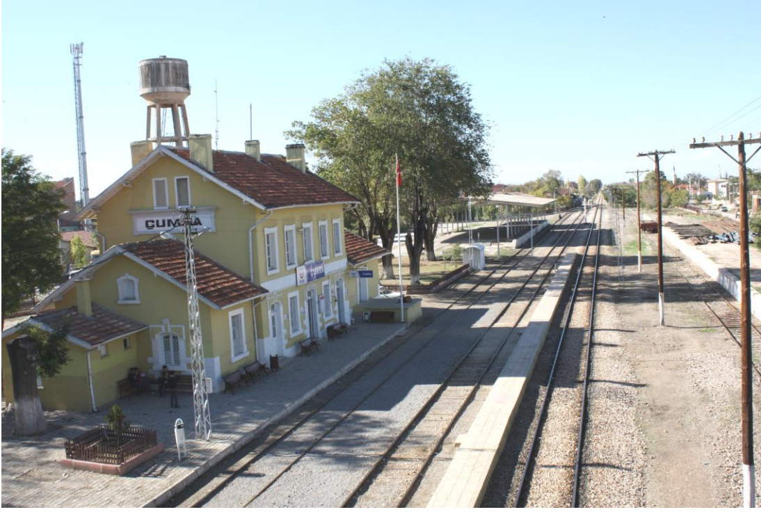
Foto-11: Hicaz Demiryolu Üzerinde Bulunan Çumra Tren Garı
