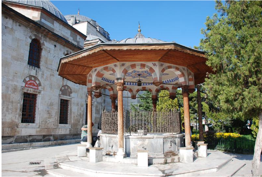
Güney cephede yakın zamanda yapılan şadırvan
