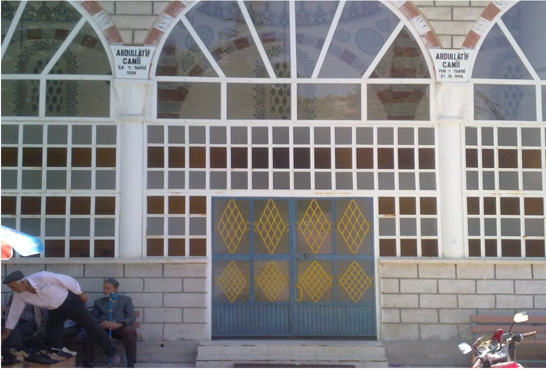
Fotoğraf: 14 Gargara/Güneyyurt Köyü Abdullatif Camii girişi.
