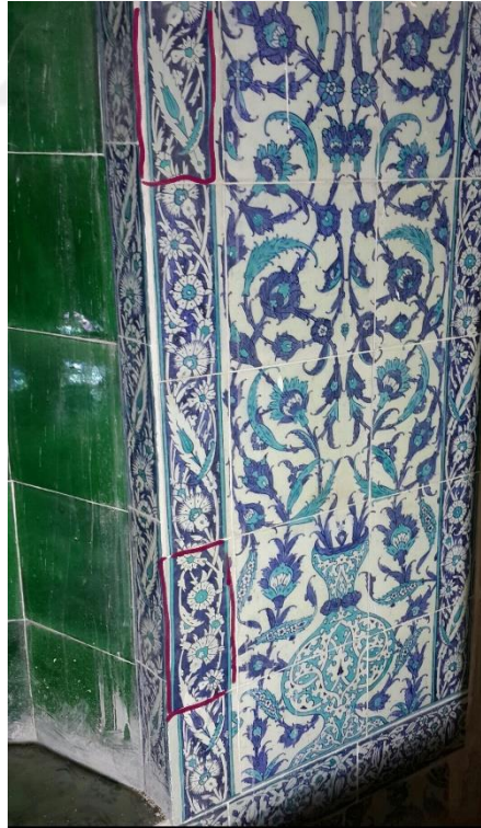
Resim 73: Kalemişi Tamamlanmış Kısımlar
