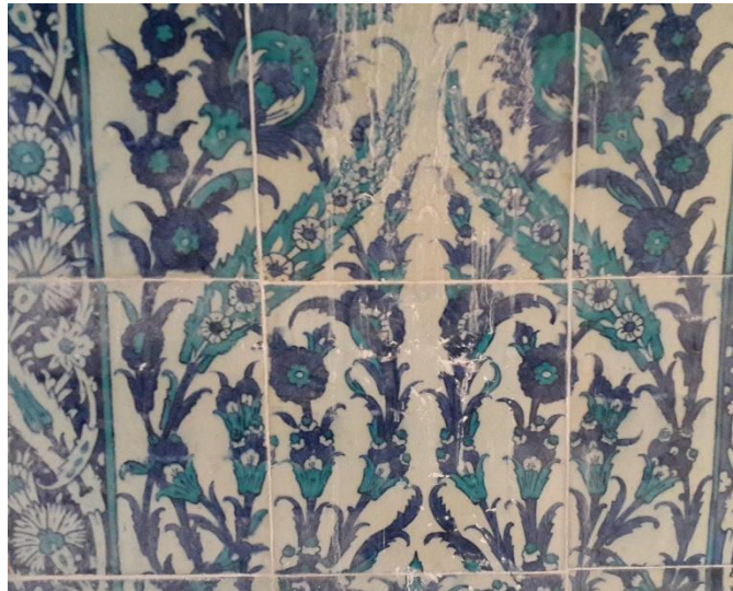
Resim 66: Derz Boşlukları Düzenlenmiş Hali
