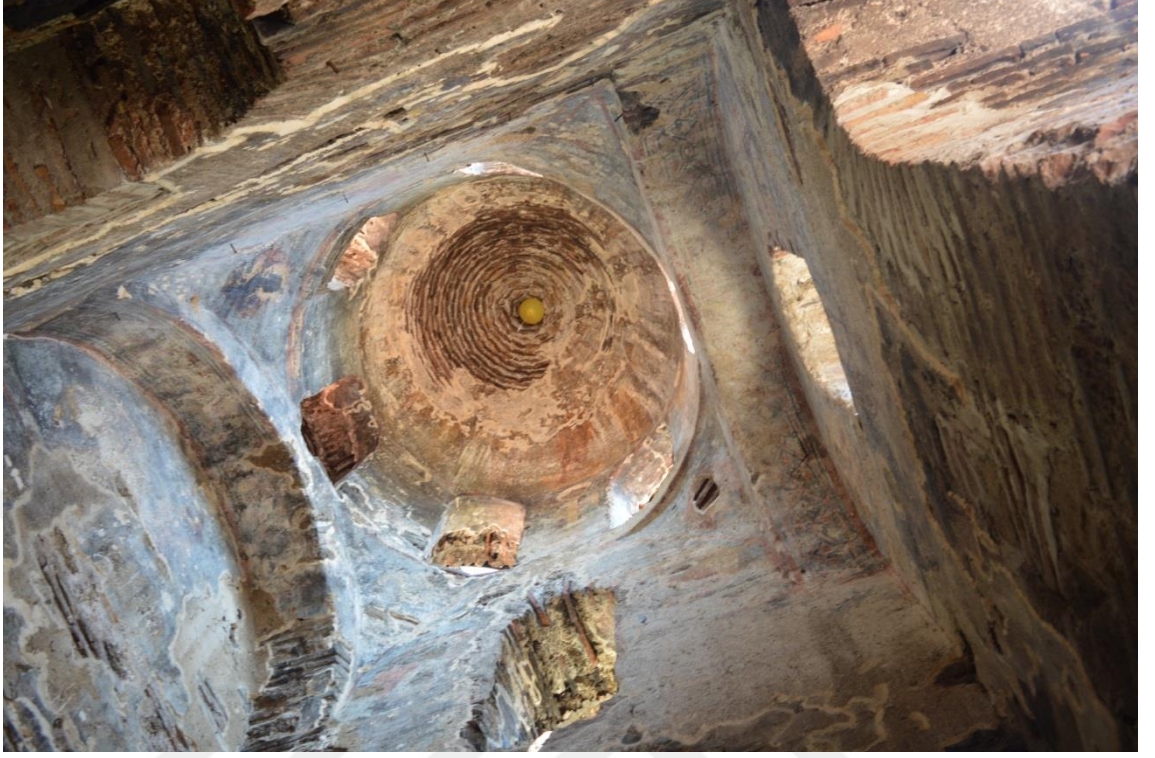
EK 14: Azize Sofya Kilisesi/ Ayasofya Orhan Camii içi. Arşivimden
