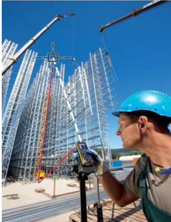
Resim 3.2. Erişilmesi güç olan yerde lazer metreyle üçgenleme yaparak ölçme
