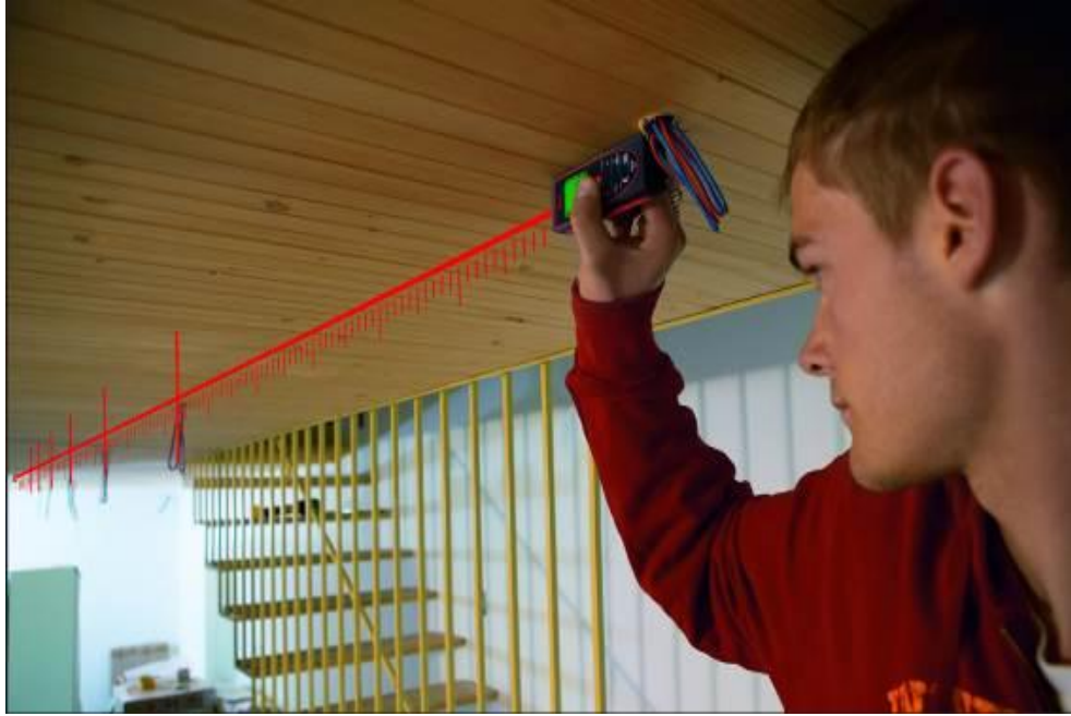
Resim 2.4. Üçboyutlu ölçüm cihazı ile rölöve alınması
