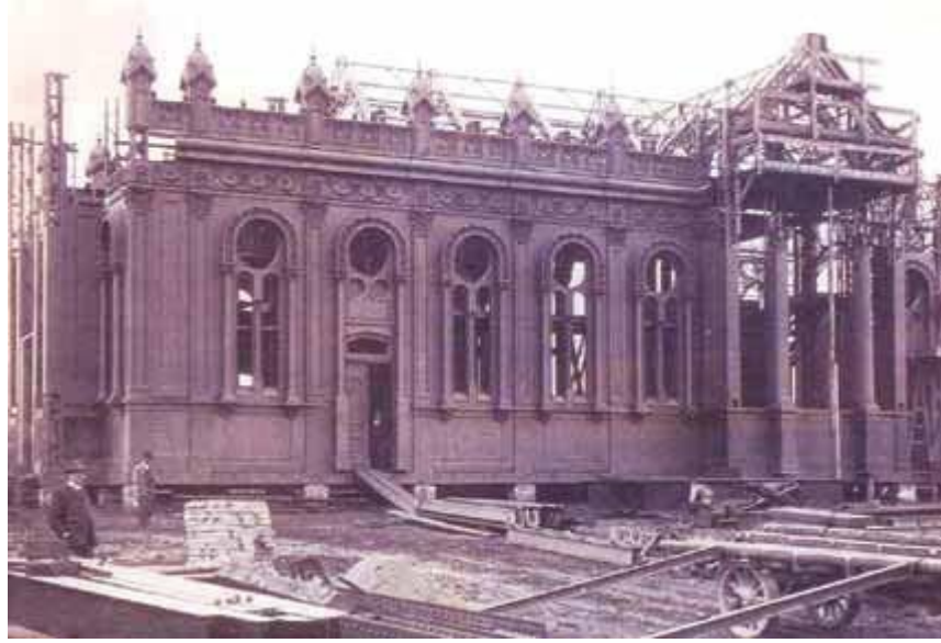
Resim 2.16. Demir kilise ön montaj (Görsel: http://muharremcaglan.blogspot.com.tr/2011/02/balat-bulgar-kilisesi.html )
