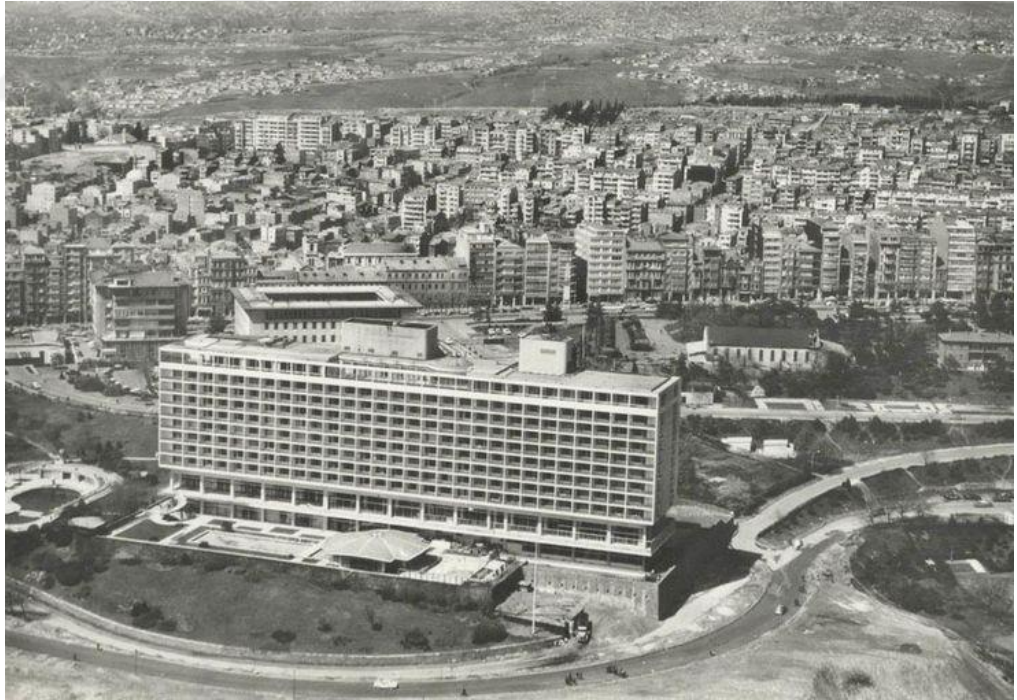
Şekil 8. İstanbul Hilton Oteli Görünüşü
