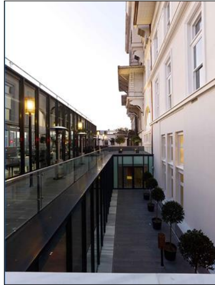
Resim-5.65. (Vitra, 2011). Ek bina ile ana binanın bağlantısı.
