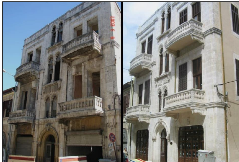
Resim-2.24. (Caner, 2015). Hatay'da onarılmış bir konutun cephesi.
