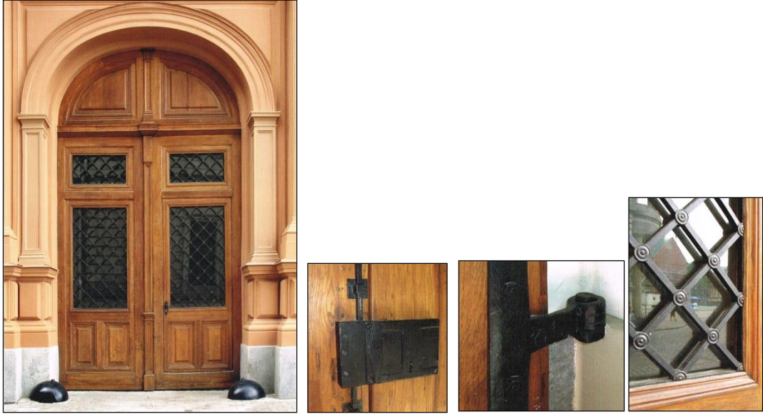
Resim-4.38., 39., 40. ve 41. (LNMM, 2011, s.68). Ana kapılardan bir tanesi ve yenilenen demir parçaları.
