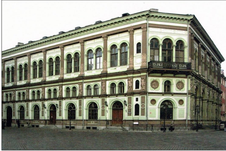
Resim-4.36. (LNMM, 2011, s.32). Yapının onarım alıřmasından nceki yeřil-beyaz boyalı grnm.
