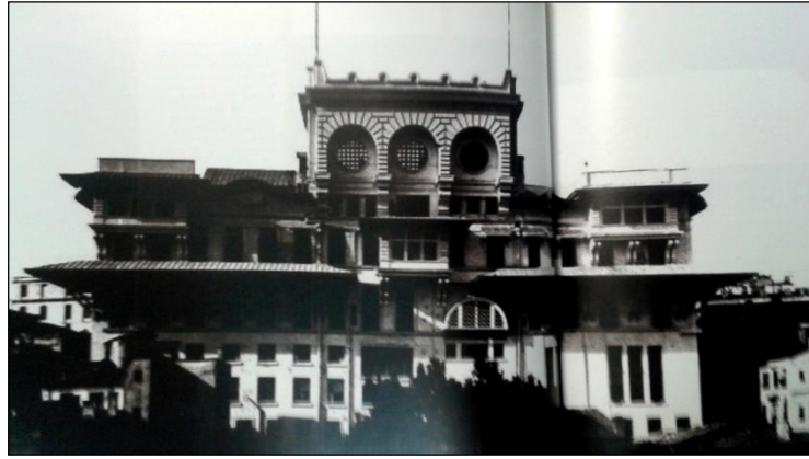
Resim-5.18. (Eldem, 2000). Yapının ilk yıllarından güney cephesi görüntüsü.
