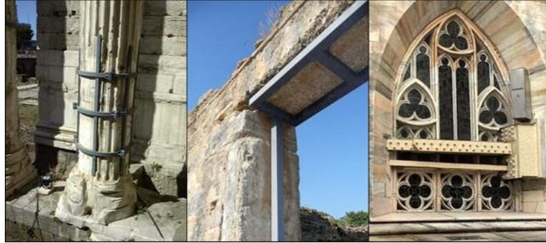
Resim- 2.25. (Constructitalia, 2015). Farklı kolon sağlamaştırma yöntemleri.
