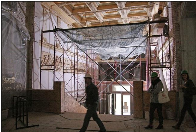
Resim-5.72. (Binder, 2011). Girişin onarım süreci.
