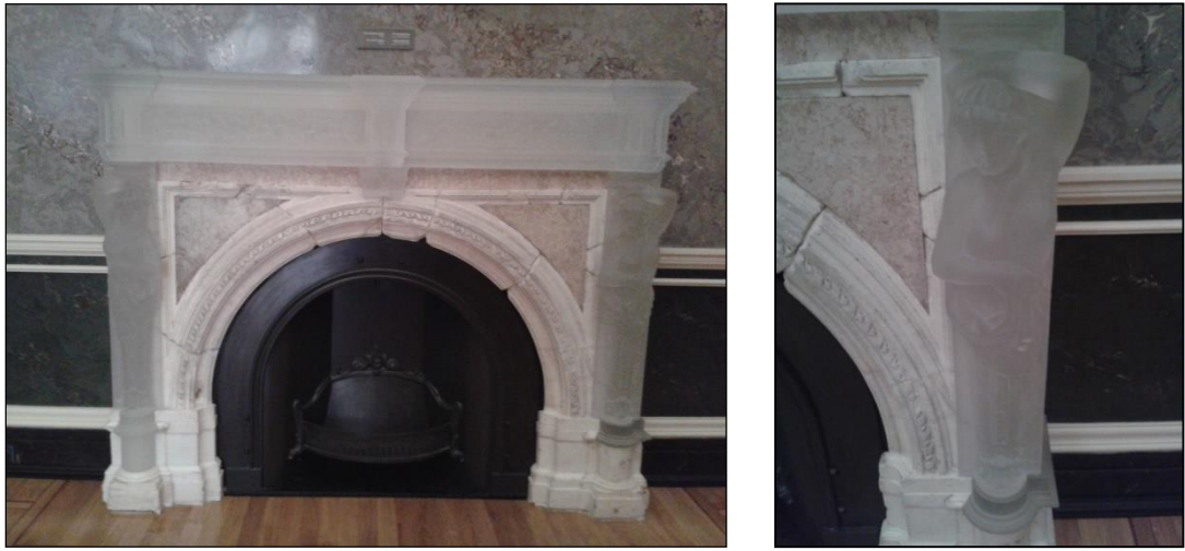
Resim-4.91. ve Resim-4.92. (Nilgün Rengin Sazak arşivi, 2014). Makart Salonu'ndaki (Yemek Salonu) şöminenin şeffaf malzemelerle onarılmış hali.
