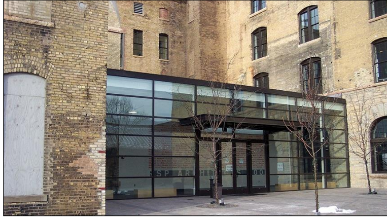
Resim-2.40. (Grimmer & Weeks, 2010) Yapıya yeni bir giriş sağlayabilmek için tasarlanmış ek giriş.
