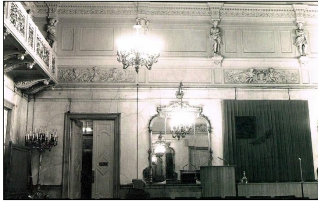
Resim-4.80. ve Resim-4.81. (LNMM, 2011, s.36). Venedik Salonu'nun (Dans Salonu) 1980'deki yangından önceki hali.
