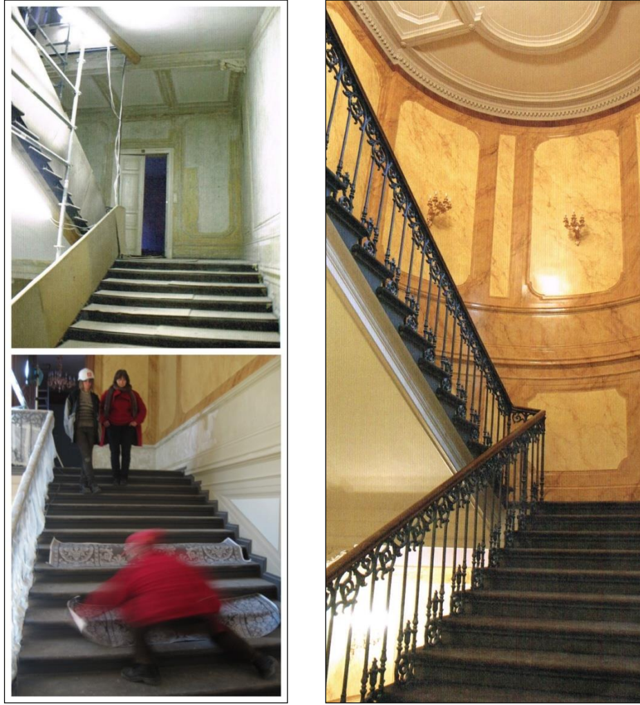
Resim-4.62. (AIGSIA arşivi, 2014). Resim-4.63. ve Resim-4.64. (LNMM, 2011, s.81). Merdivenlerin onarım aşaması ve son durumu.
