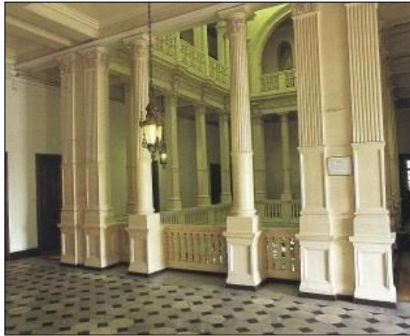
Resim-5.82. ve Resim-5.83. (Eldem, 1997, s.140). Orta avlu ve onu çevreleyen sütunların, yapının ilk yıllarında yapılmış bir illüstrasyonu ve onarılmadan önceki hali.
