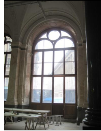
Resim-4.58. (Nilgün Rengin Sazak arşivi, 2014). Resim-4.59. (AIGSIA arşivi, 2014). Galerideki aydınlatmalar ve meşe pencerelerin onarım süreci.
