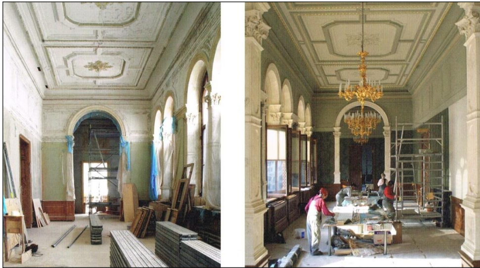
Resim-4.93. (LNMM, 2011, s.66). Batı Galerisi'nin onarım süreci.
