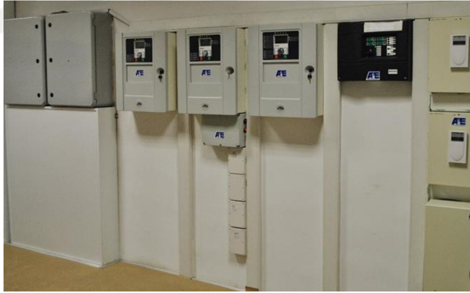
Şekil 4.4 Via Green kontrol merkezinde bulunan yangın uyarı panelleri (Foto: Kişisel arşiv, 2017)
