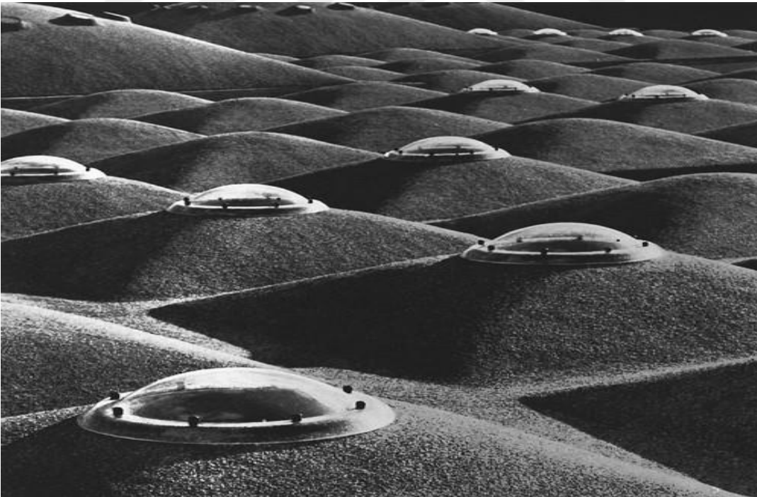
Görsel 4.28: Amsterdam Yetimhanesinin ana biçimini oluşturan ve ışık almasını sağlayan, modüller. Elektronik Kaynak: http://www.archdaily.com/151566/ad-classics-amsterdam-orphanage-aldo-van-eyck/50380f0028ba0d599b000bd5-ad-classics-amsterdam-orphanage-aldo-van-eyck-photo Son Erişim: 05/09/2017
