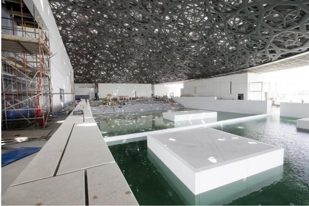
Görsel 5.82 : Abu Dhabi Louvre müzesinin iç mekanlarını soğutan su havuzları ve kubbe Elektronik Kaynak: http://www.abudhabi2.com/the-tide-turns-at-louvre-abu-dhabi-as-the-sea-becomes-museums-first-attraction/ Son Erişim: 05/09/2017
