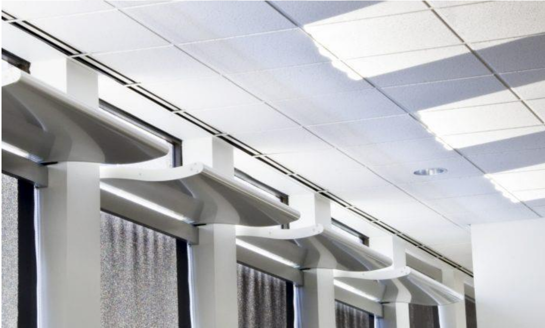
Görsel 78: Işık Rafları en ekonomik ve basit güneş ışığı kullanma sistemlerinin başında gelir. Elektronik Kaynak: http://energykade.com/2016/05/17/4-great-methods-to-bring-sun-light-into-your-dark-rooms/ Son Erişim: 05/09/2017
