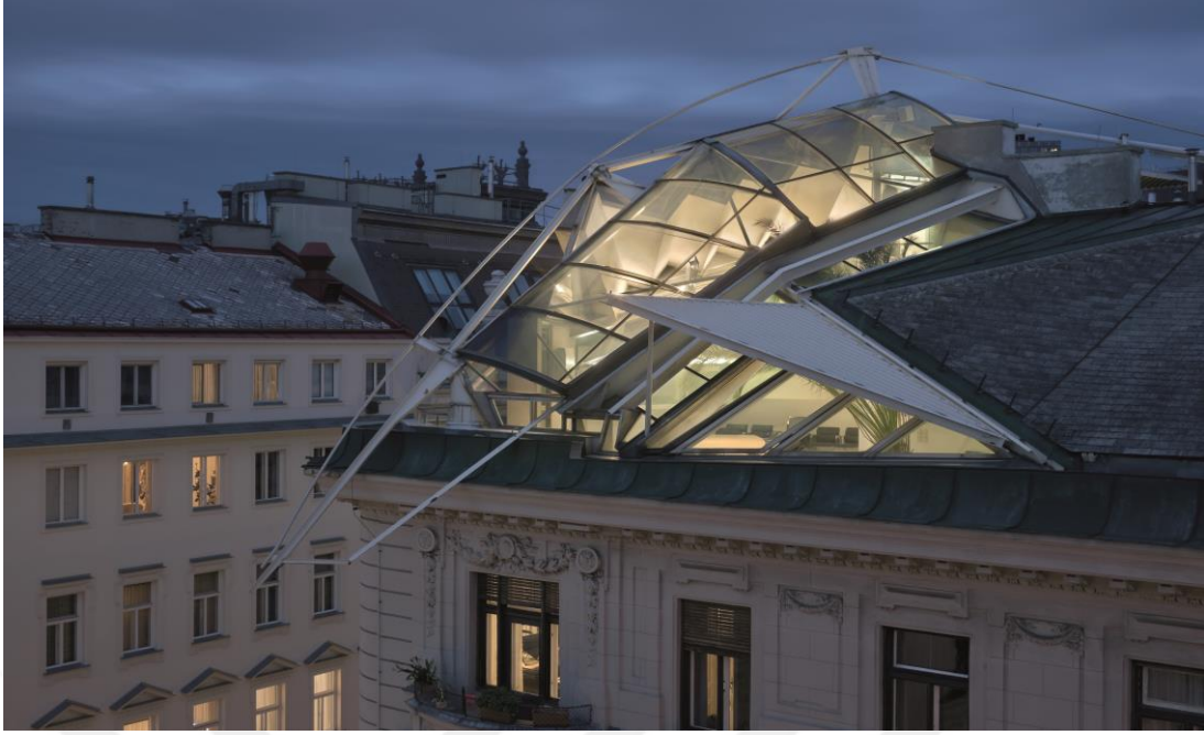
Görsel 3.18: Rooftop Remodelling, Falkestrasse, Himmelblau'nun pratiğe döktüğü ilk dekonstrüktivist yapı. Elektronik Kaynak: Kaynak: http://www.coop-himmelblau.at/download/ Son Erişim: 05/09/2017
