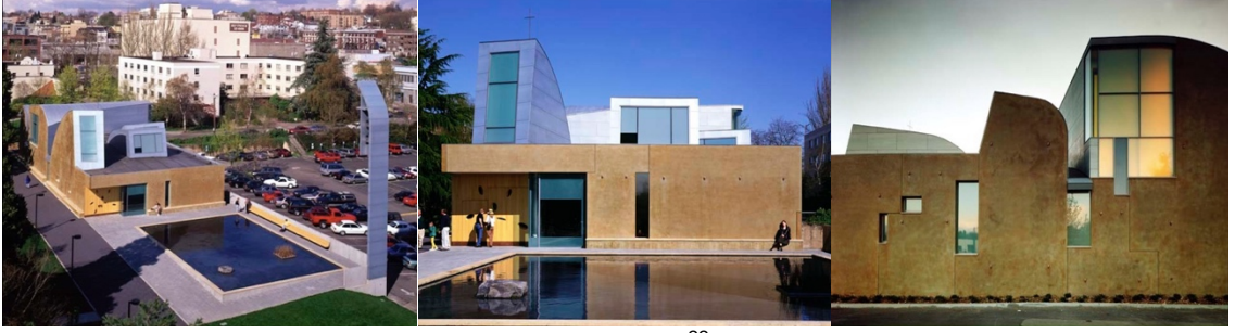
Şekil 10: Chapel of St. Ignatius dış cephe görüntüleri 22
