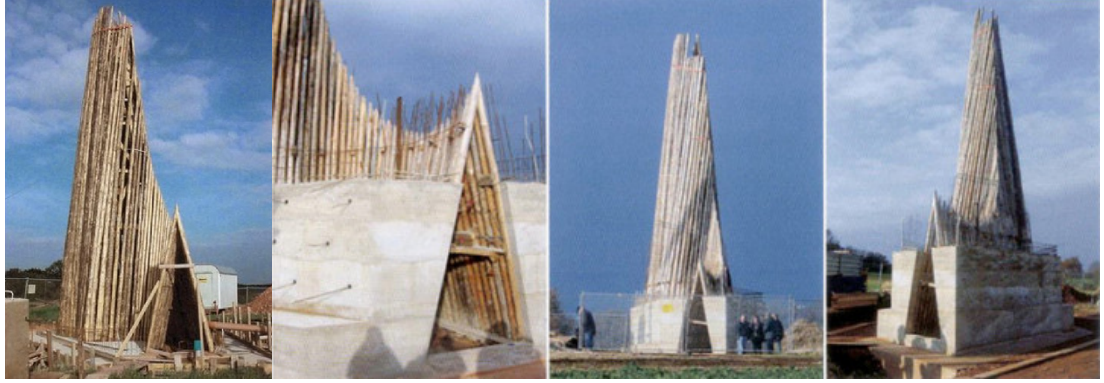
Şekil 22: Bruder Klaus Field Şapeli Yapım Aşaması 41
