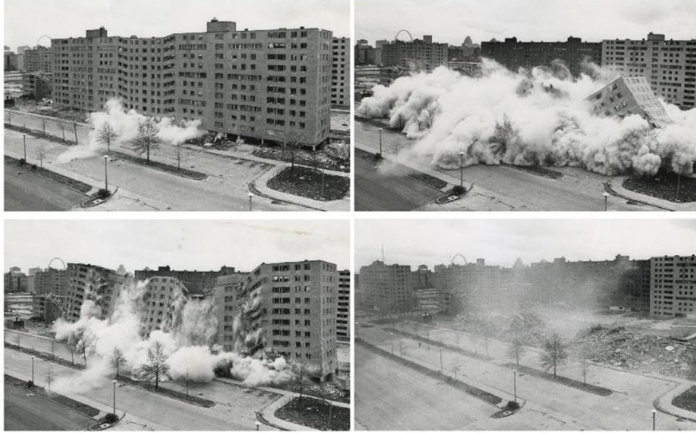
Görsel 2: Pruitt-İgoe Konutlarının Yıkılışı, Kaynak: https://politecture.wordpress.com/2011/11/25/pruitt-igoe/
