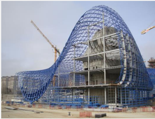
Şekil 5.2.3.12. Haydar Aliyev Kültür Merkezi Yapım Aşamasından Görünüm www.buildpedia.com
