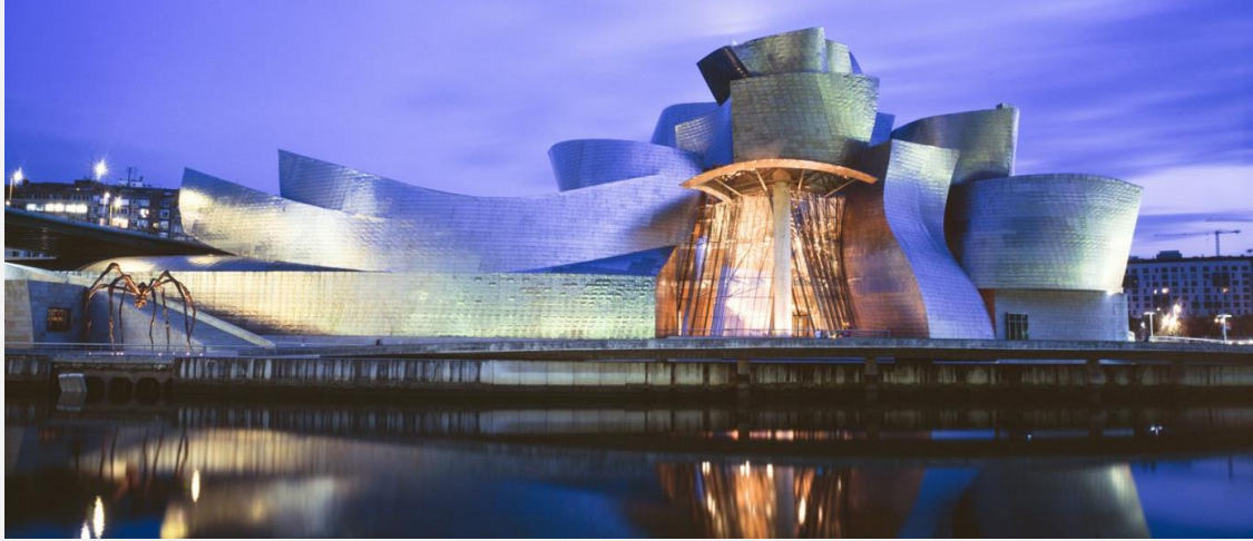
Şekil 5.2.5.1. Guggenheim Müzesi Nehirden Görünüm, www.guggenheim-bilbao.es/
