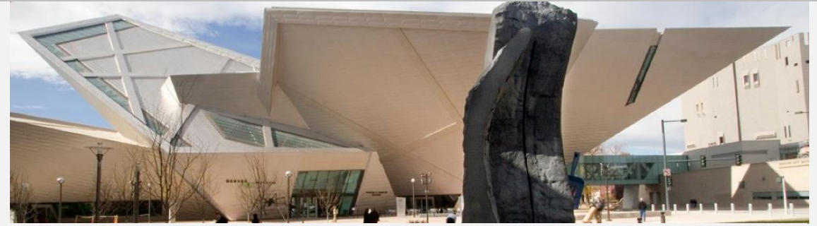
Şekil 5.2.10.11. Denver Sanat Müzesi Ön Görünüş, https://libeskind.com/work/
