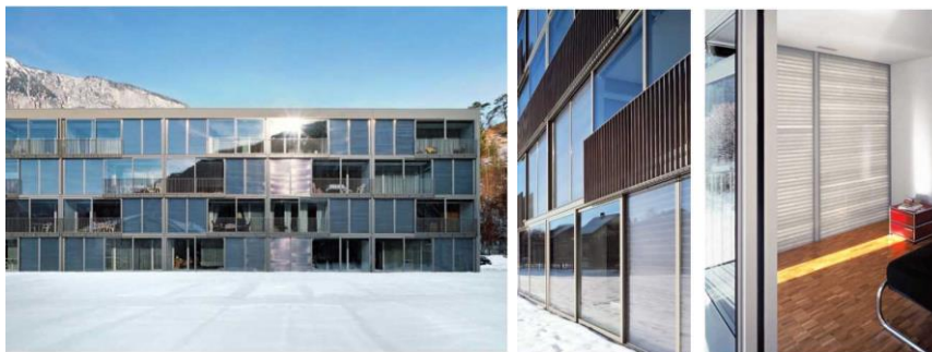
Resim 58. 'Senior citizens' Apartmanı: Akıllı malzemenin ısı depolanması, Faz Değiştiren Akıllı Malzeme ile Yalıtımlı Cam (Tuz Hidroliji), Güneş Işınlarının Akıllı Yönetimi, Dietrich Schwarz, Domat/Ems, İsviçre,2004.
