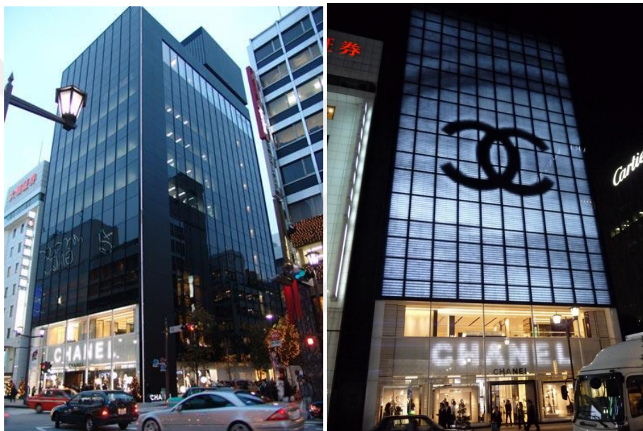
Resim 88. Chanel Ginza Binası, Tokyo, Japonya, Peter Marino, Tanteri + Associates, 2004. Gündüz şeffaf cephe, gece opak medya ekranı görüntüsü (URL-61).
