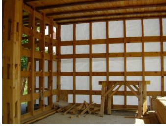
Resim 13. Ahşap Dikme Taşıyıcı Duvar (Cengiz, 2008).
