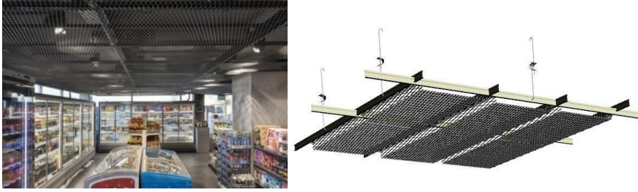
Resim 28. Alüminyum Genişletilmiş Metal (mesh) Asma Tavan (URL-17, 2018).
