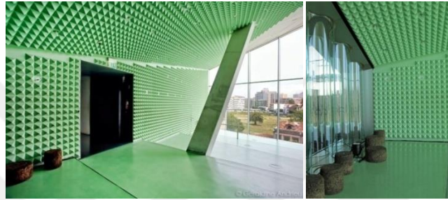
Resim 31. Tavan ve Duvarda Melamin Formaldehit Malzeme Uygulaması, Casa da Musica, OMA, Porto, 2005 (URL-20, 2018)
