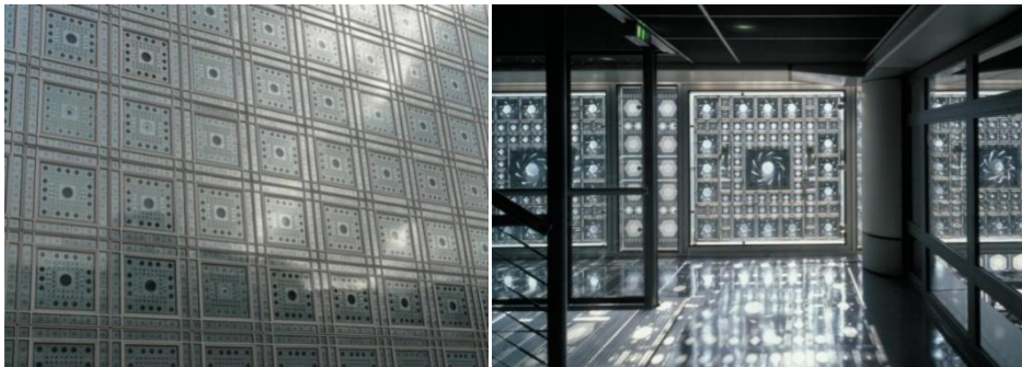
Resim 35. Institut du Monde Arabe yapısında cephe panelleri (URL-22, 2018)
