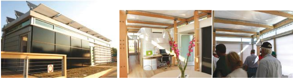
Resim 69. Solar Decathlon, Aerojel Dolgulu EFTE Kaplı Çatı Panelleri (iç-dış tavan yüzeyi), Georgia Üniversitesi Binası, ICARUS, ABD,2007 (Altın, Aşıkoğlu 2014).
