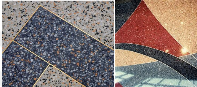
Resim 21. Beton ve Çimento Esaslı Terrazzo Zemin Uygulama (URL-9, 2018).
