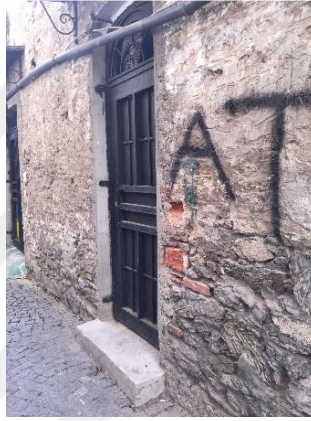
Resim 82: Yapı ile istinat duvarı arasında kalan koridor kısmında boyanmış olan duvar (Begüm Gökdağ Arşivi, 2018)
