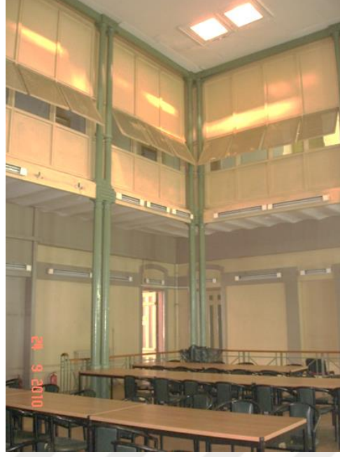
Resim 55: Renovasyon öncesi Hamlin Hall'un zemin katı (Yapı İşleri, 2010)
