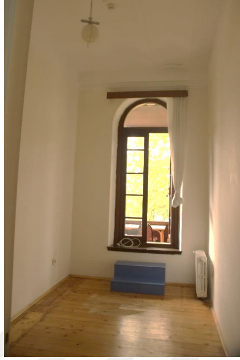
Resim 60: Yurt mdrnn lojmanı. İptal edilen balkon kapısı yerine kullanılan basamaklı pencere (Begm Gkdađ Arşivi, 2018)
