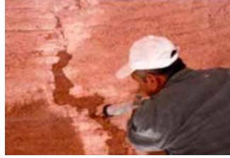
Resim 14: Fatih Camii restorasyonunda çatlakların enjeksiyon ile onarılması
