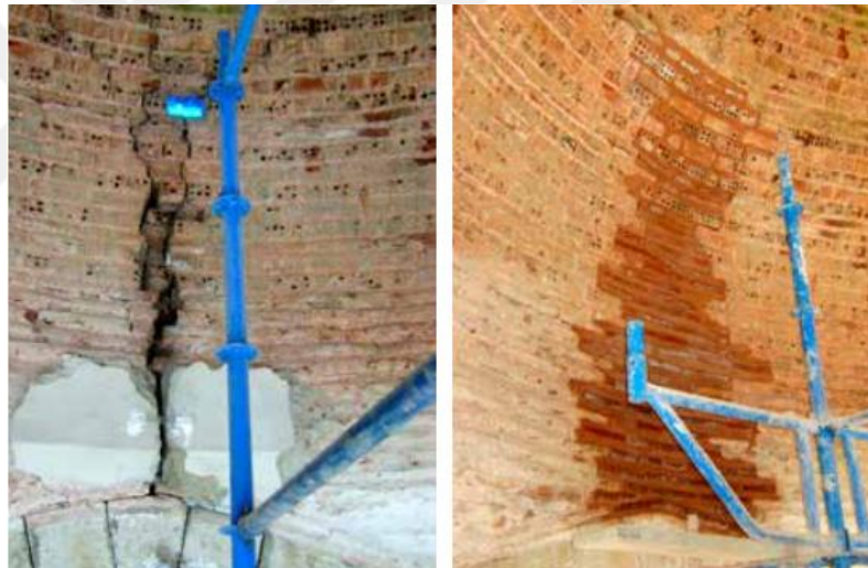
Resim 15: Fatih Camii restorasyonu sırasında yapılan dikiş uygulaması
