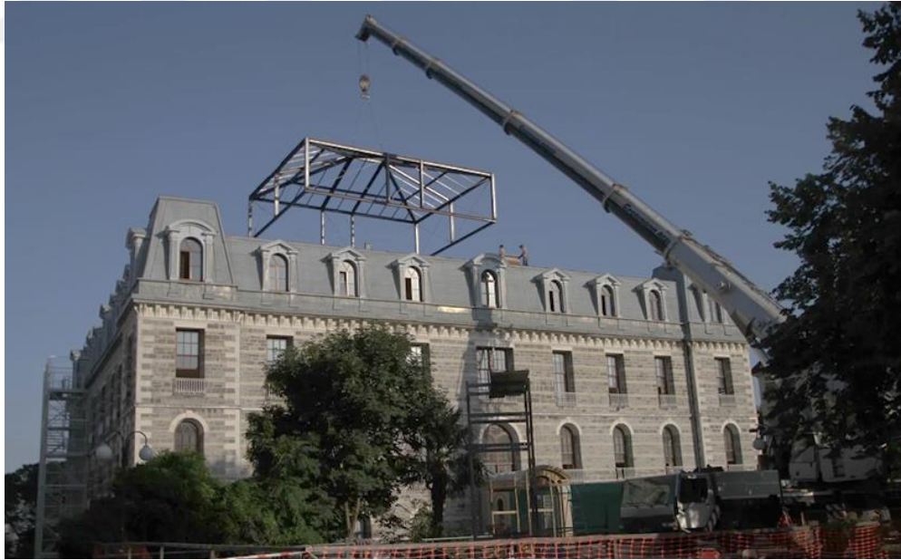
Resim 66: Tavan camının uygulanma anı (Yapı İşleri, 2010)
