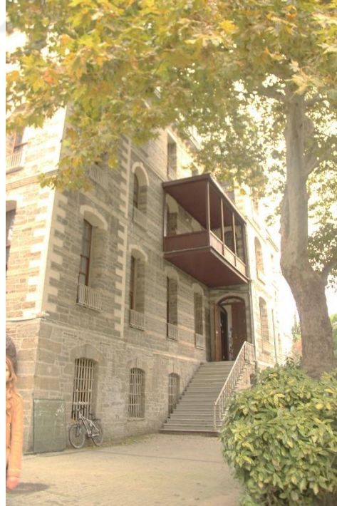
Resim 63: Lojman balkonunun arka cepheden görüntüsü (Begüm Gökdağ Arşivi, 2018)
