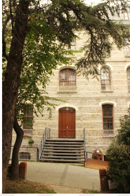
Resim 50: Yangın merdiveni çıkışının cephe görünümü- Batı cephesi (Begüm Gökdağ Arşivi, 2018)
