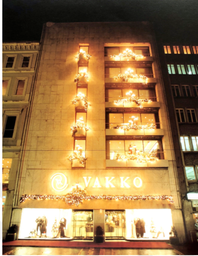
Resim 5.7: İstanbul Beyoğlu Vakko mağazası dış cephe
