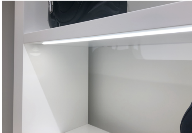
Resim 5.66: Atakule Vakko mağazası lokal aydınlatma detayı
