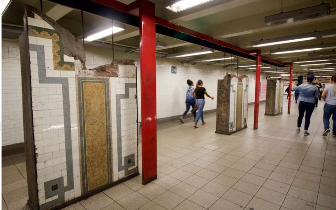
Görsel 49 a) Korunan eski istasyon duvarları ( https://bit.ly/2OEqiFo ).
