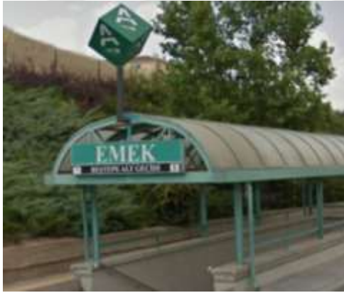
Görsel 106 a) Emek İstasyonu.
