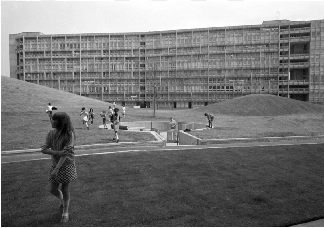
Şekil 52. Toplumsal ilişkiler üzerine biçimlenen yapılar, alanlar, Robin Hood Gardens, Londra, Alison ve Peter Smithson, 1972. Kaynak: https://bit.ly/2UkhOqv
