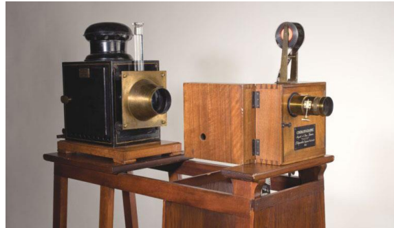
Görsel 91. 1895 yapımı, Lumiere marka bir sinematograf. Soldaki siyah kutu bir fener, sağdaki kutu ise resimlerin geçmesini sağlayan bir kinetoskop ve aynı zamanda bir kamera. (Rai, 2017) Erişim: 09.01.2019
