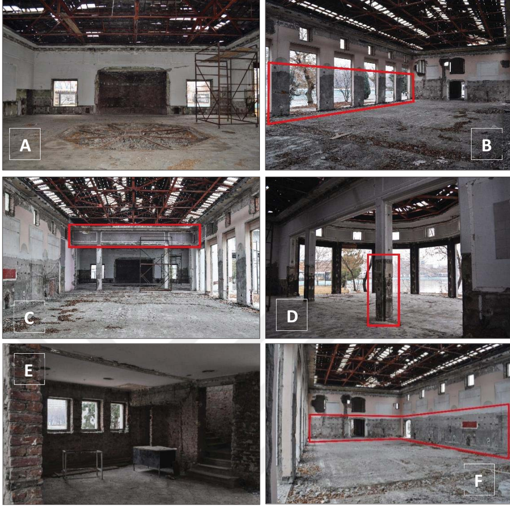
Görsel 71. Göl Gazinosu Yapısının Yenileme Öncesi İnşaat Hali Fotoğrafları, A: Sahne Kısımı, B: Lokanta-Giriş Kısımı, C: Girişten Genel Perspektif, D: Kuzey Kısımı, E: Giriş Kısımı, F: Lokanta Kısımı, Güney Cephesi, Umut Şumnu Arşivi, 2012
