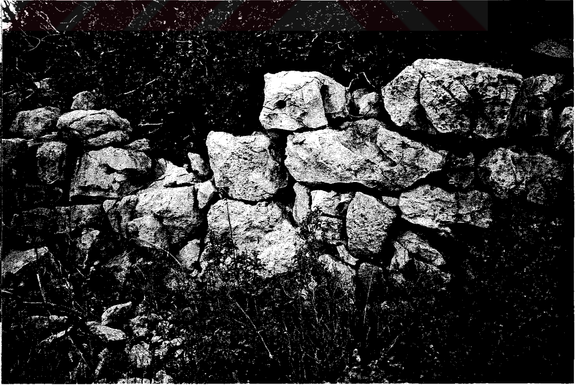
b- Çamlı Ören Tepe, Kule güney duvarı
