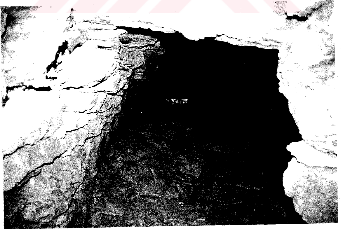
b- Çamlı Sandal Tepe, Kule iç mekanda doğu girişi
