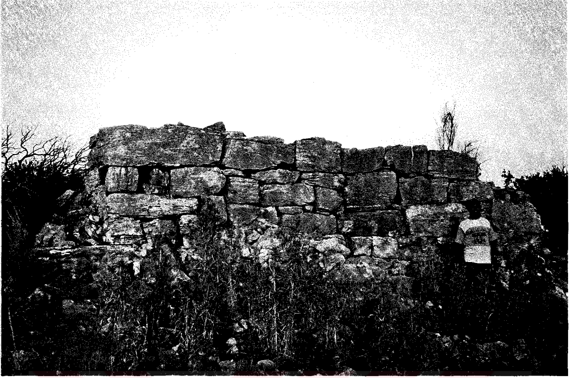
a- Çamlı Kezbel Kule batı duvarı
