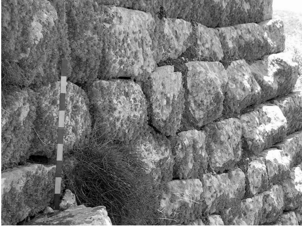
Res.1: Ouranion, düzensiz rektagonal taşlardan inşa edilmiş iç kale duvarının örgüsü.
