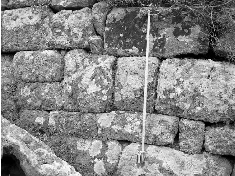
Res.2: Myndos, kuzey surlarındaki düzensiz rektagonal duvar örgüsü.
