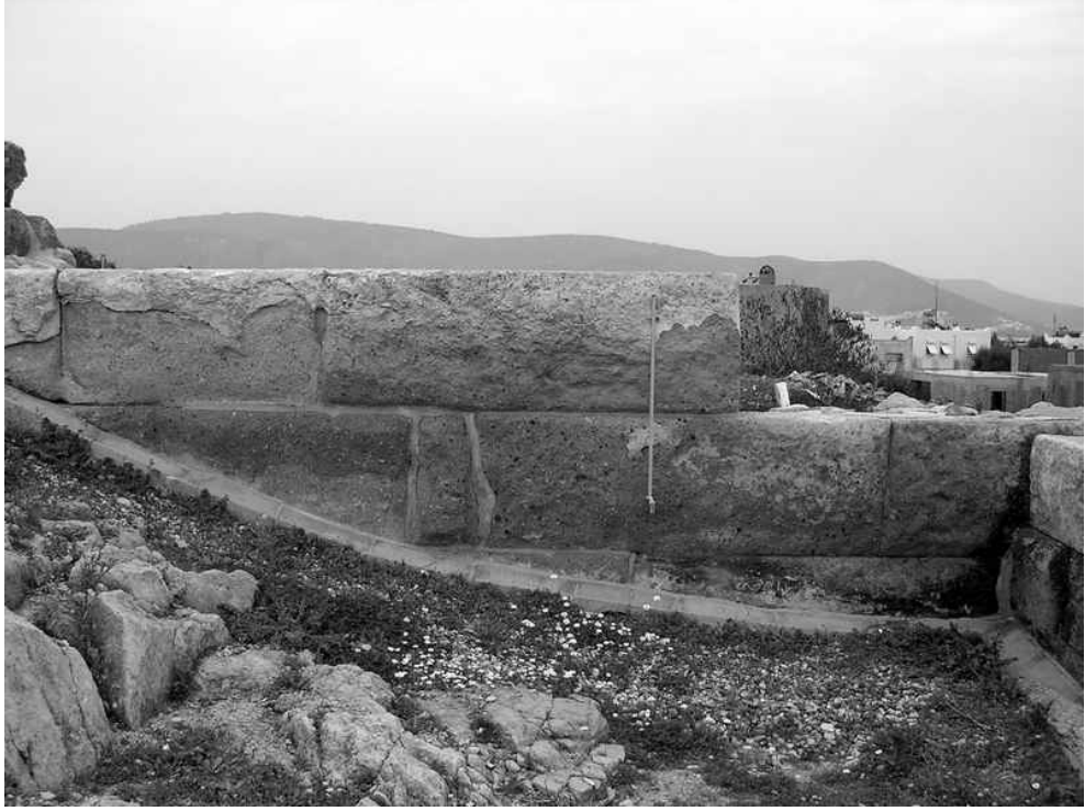
Res.1: Halikarnassos, isodomik atkılı duvar, Myndos kapısının güneyi.
