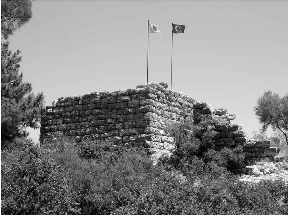
Res.2: Pedasa, İK1 ve İK2 kulelerinin güneybatıdan görünümü.
