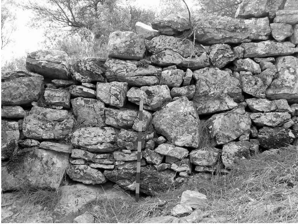
Res.2: Pedasa, dış kale duvarındaki kuru moloz duvar örgüsü.
