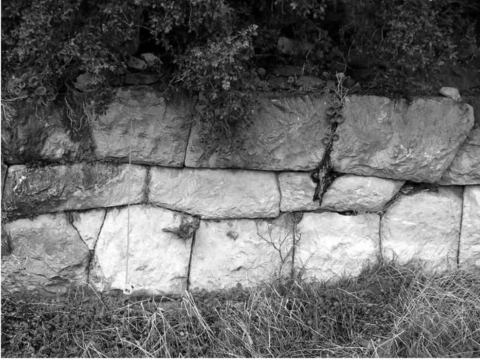
Res.2: Halikarnassos, trapezoidale yakın poligonal taşlardan duvarlar, Kazancı tepesinin güneyi.
