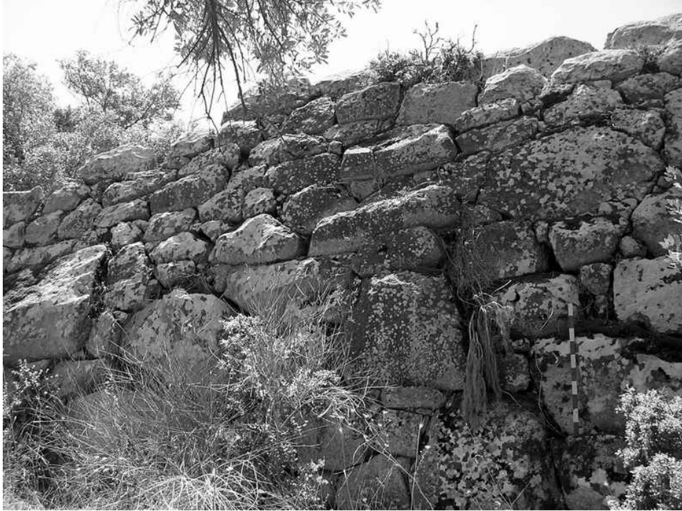
Res.2: Ouranion, poligonal teras duvarı.
