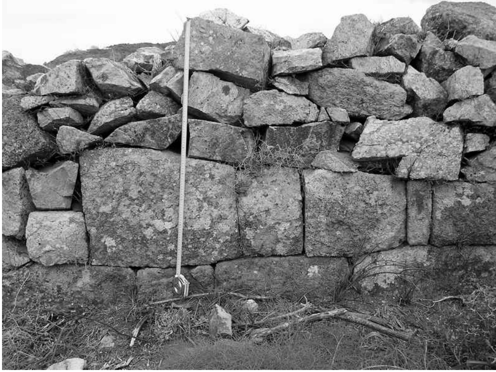
Res.1:Myndos, kuzey surlarındaki düzensiz trapezoidal duvar örgüsü.
