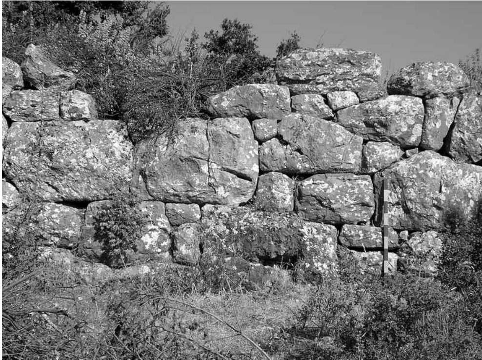
Res.2: Halikarnassos, kaba poligonal duvar, Çevrimkaya'nın güneyi.
