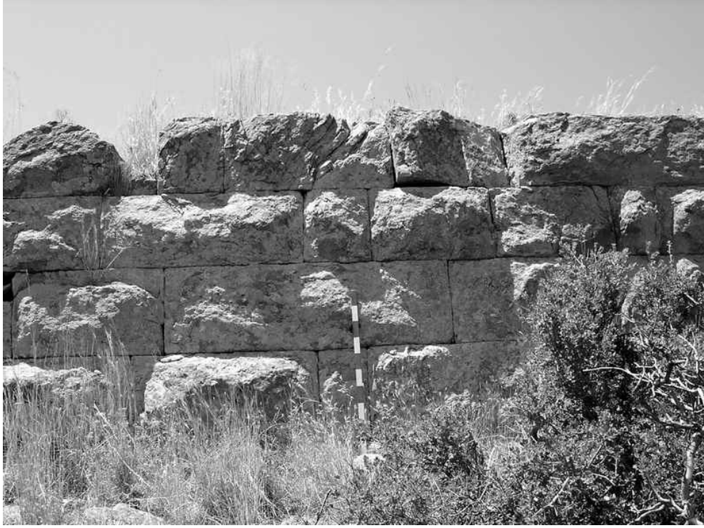
Res.1: Telmessos, zirvedeki kulenin isodomik duvar örgüsü.
