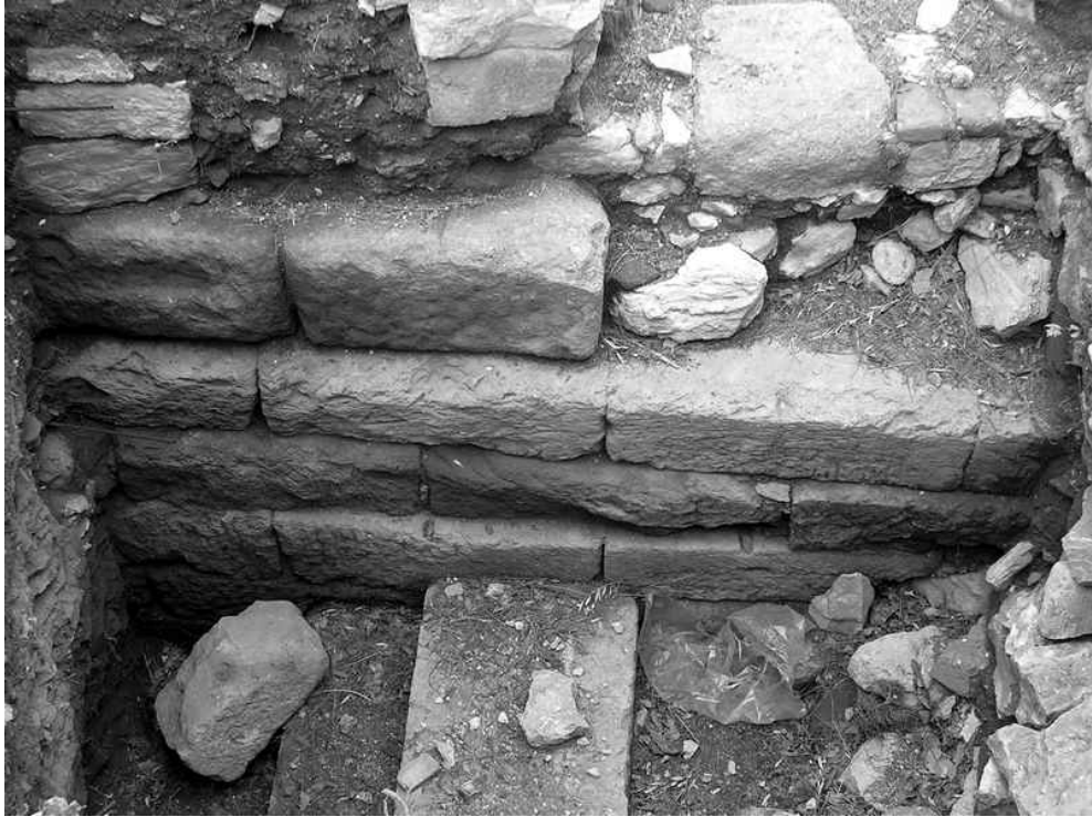
Res.2: Halikarnassos, Şövalyeler'in kalesindeki M.Ö. 4. yy duvarı.
