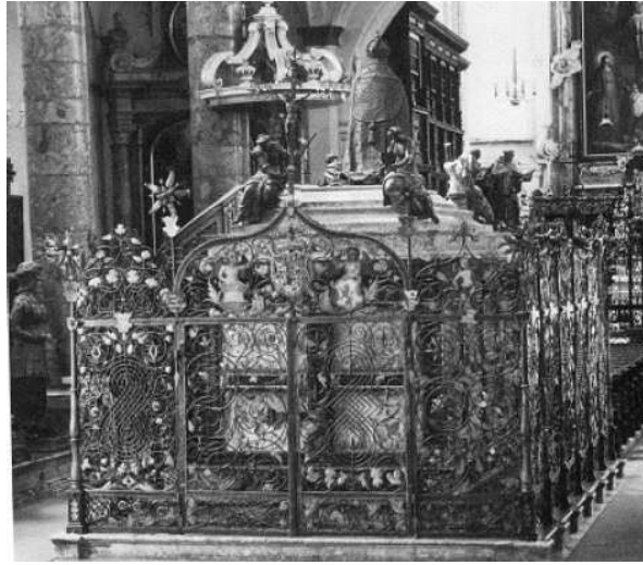
Resim 28. Anıt mezarın restorasyon öncesi kafes arkasındaki genel görüntüsü.
