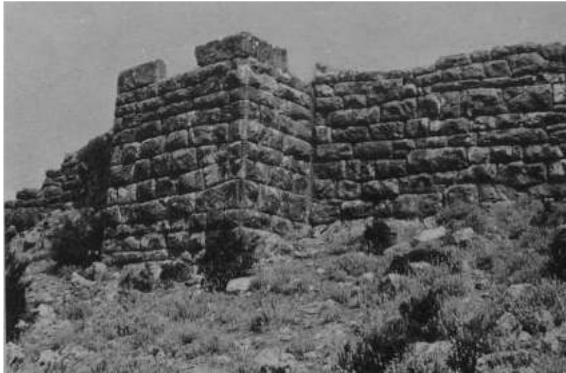
Res. 2: Panopeus, Dış sur duvarı
