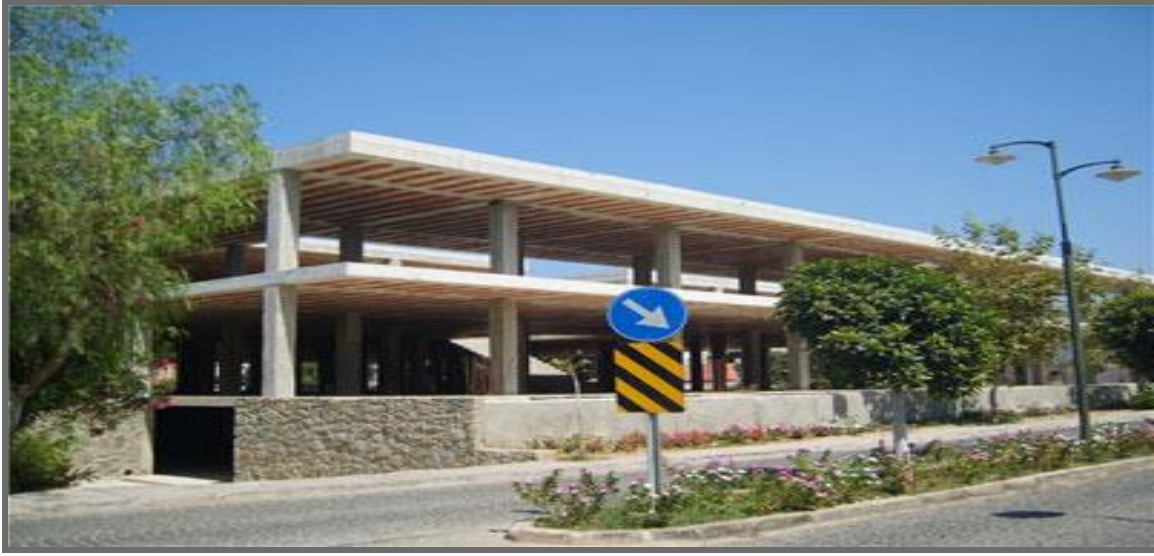
Fotoğraf 12: Yalıkavak Şehir Merkezinde Yapımı Tamamlanmayan İş Merkezi
