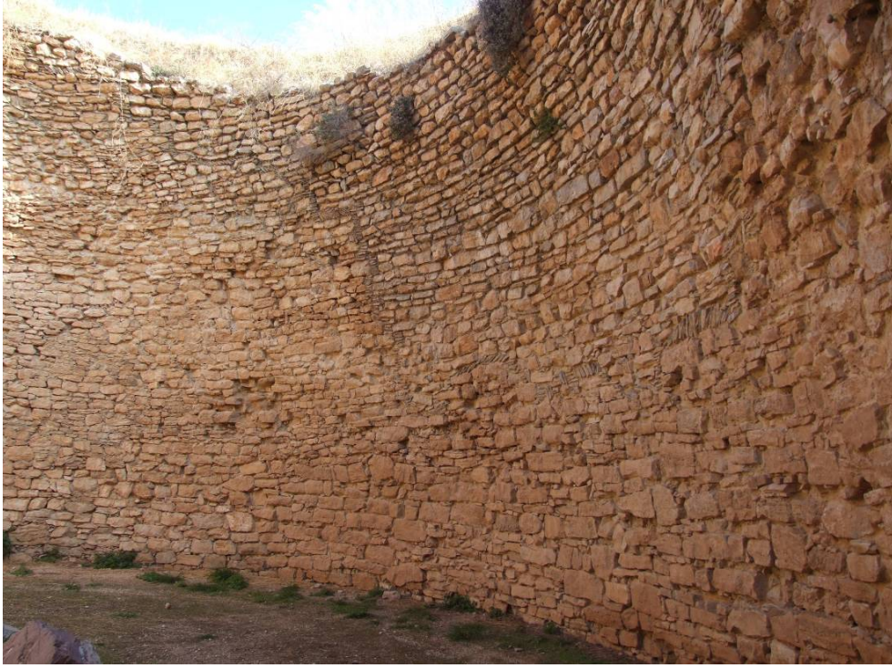
2: Aegisthus Tholos mezarının oda duvarları
