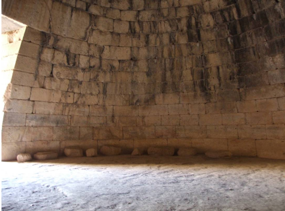
2: Atreus Tholos mezarının oda duvarları.
