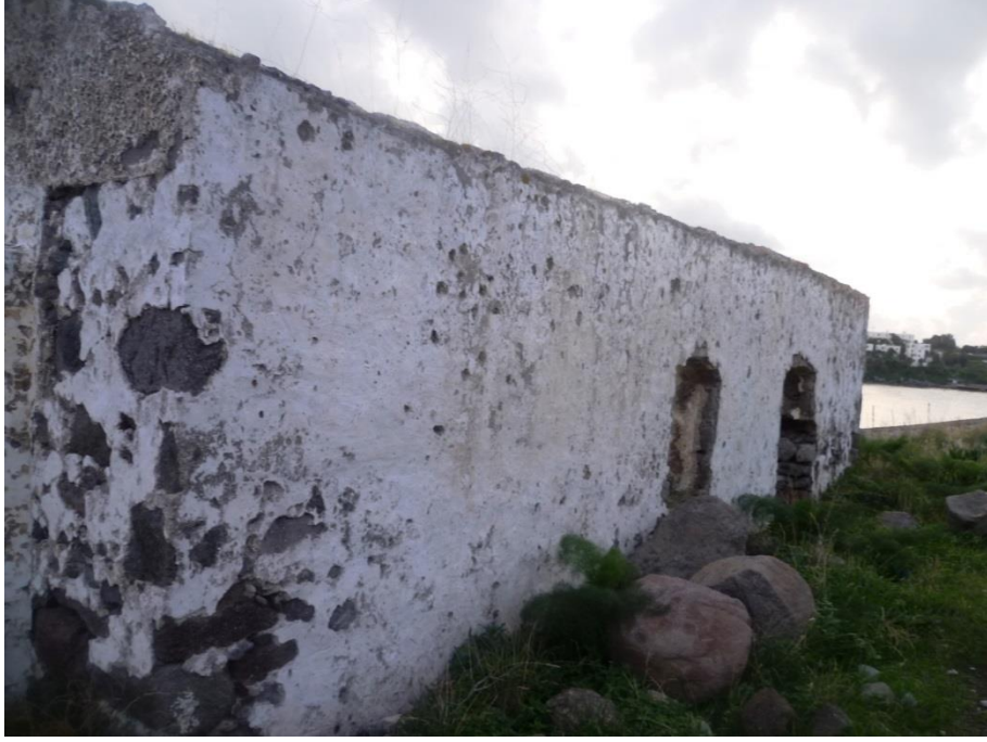
Resim 77. Bodrum Akyarlar Köyü Kilise II kuzey cephe
