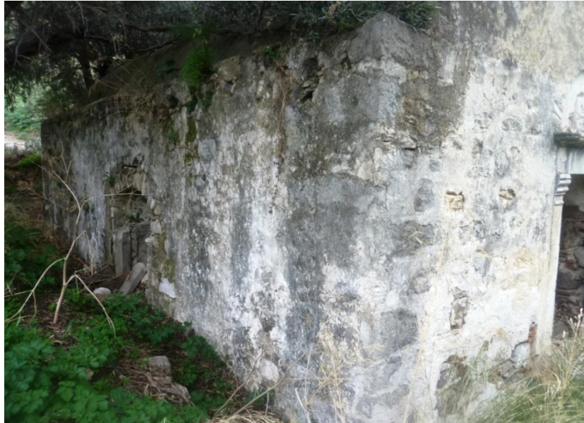
Resim 66. Bodrum Akyarlar Köyü Kilise I kuzey cephe
