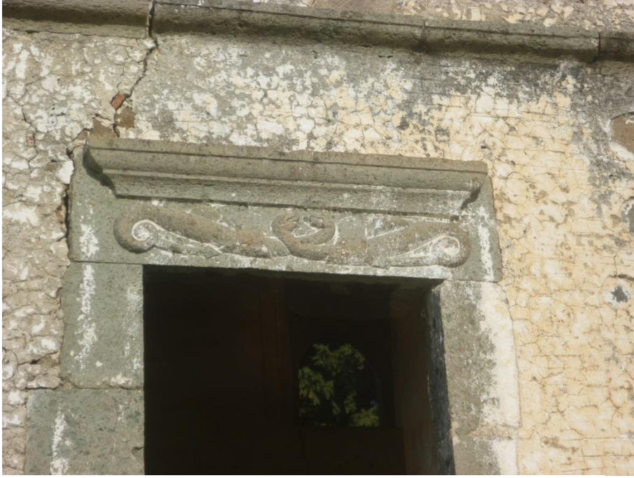
Resim 107. Bodrum Peksimet Köyü Küçük Kilise güney pencere detayı
