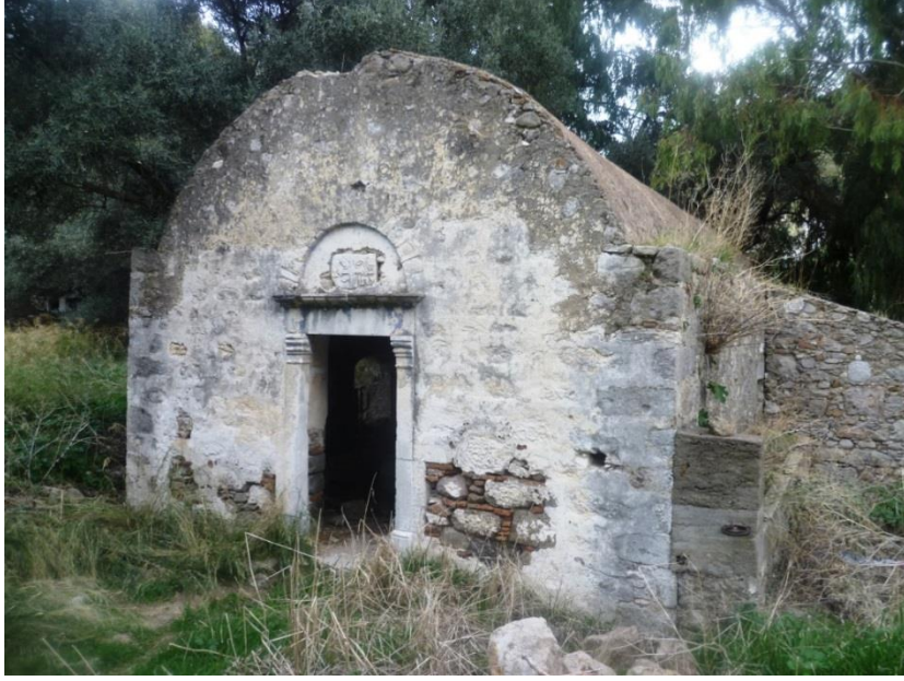
Resim 65. Bodrum Akyarlar Köyü Kilise I batı cephe
