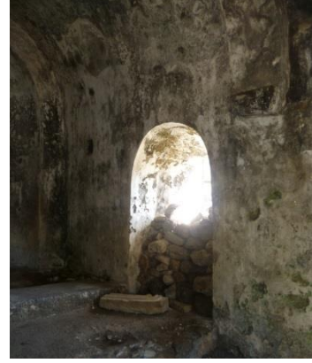
Resim 295. Fethiye Kayaköy Küçük Kilise XV güney duvarındaki pencere
