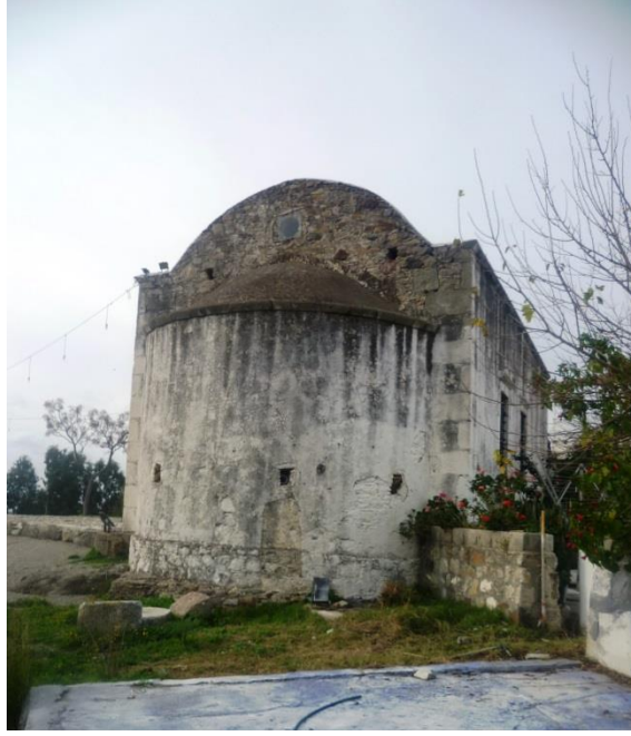
Resim 92. Bodrum Gümüşlük Eklisia Kilisesi doğu cephe
