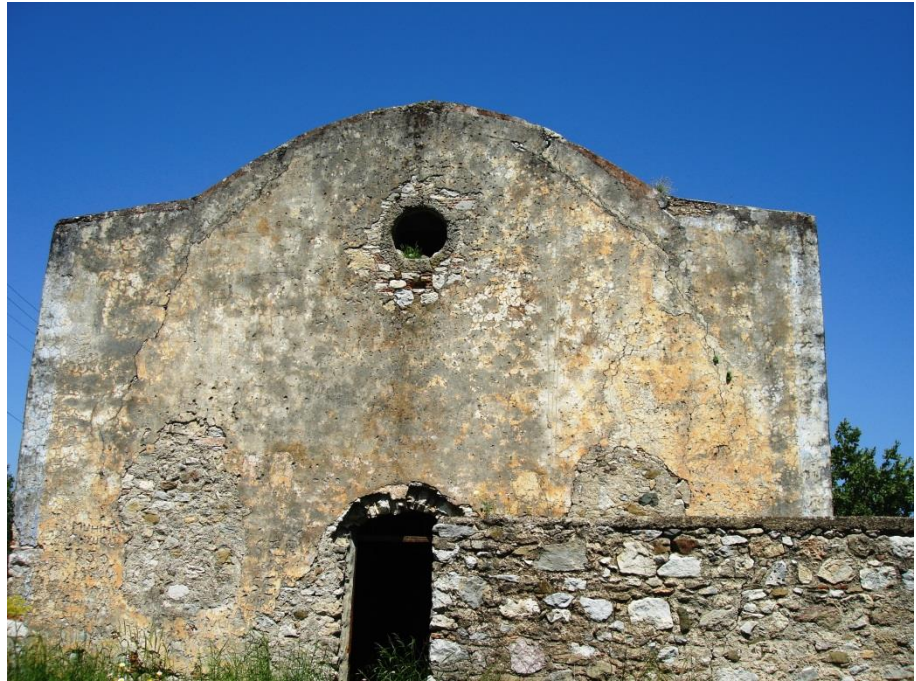
Resim 319. Datça Hızırşah Kilisesi batı cephe
