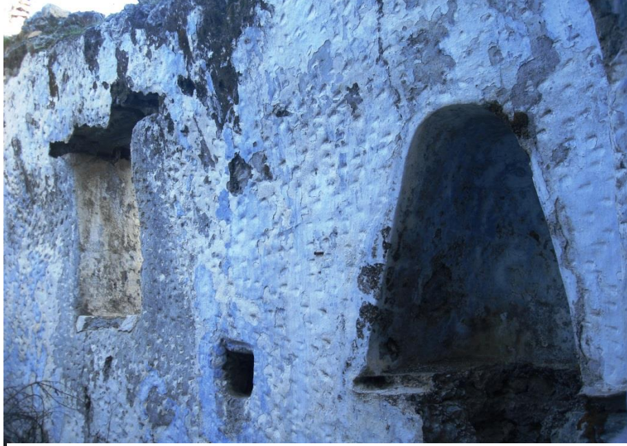
Resim 252. Fethiye Kayaköy Küçük Kilise X naos güney duvarı
