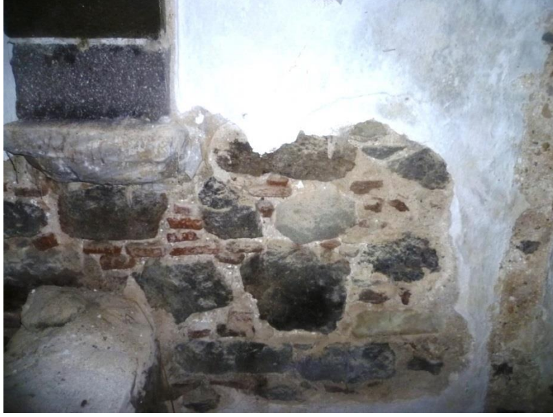
Resim 72. Bodrum Akyarlar Köyü Kilise I inşa malzemesi
