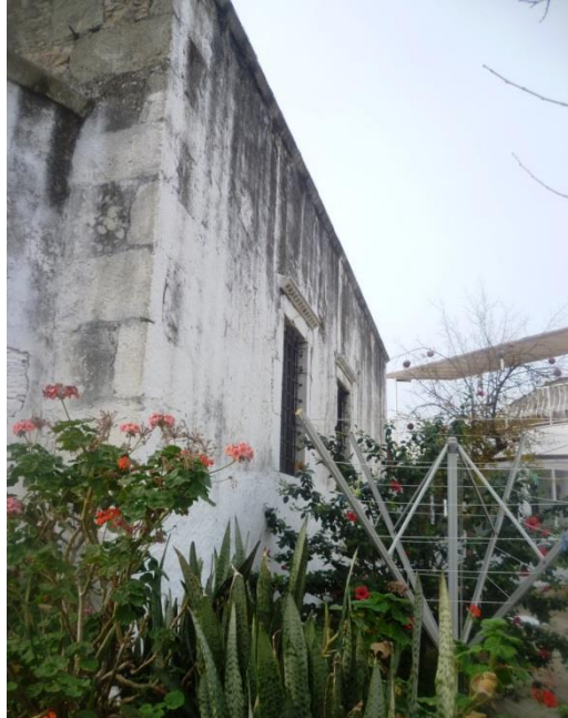
Resim 90. Bodrum Gümüřlük Eklisia Kilisesi kuzey cephe
