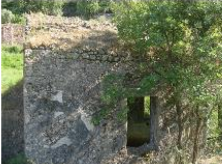
Resim 176. Fethiye Kayaköy Küçük Kilise II kuzey cephe
