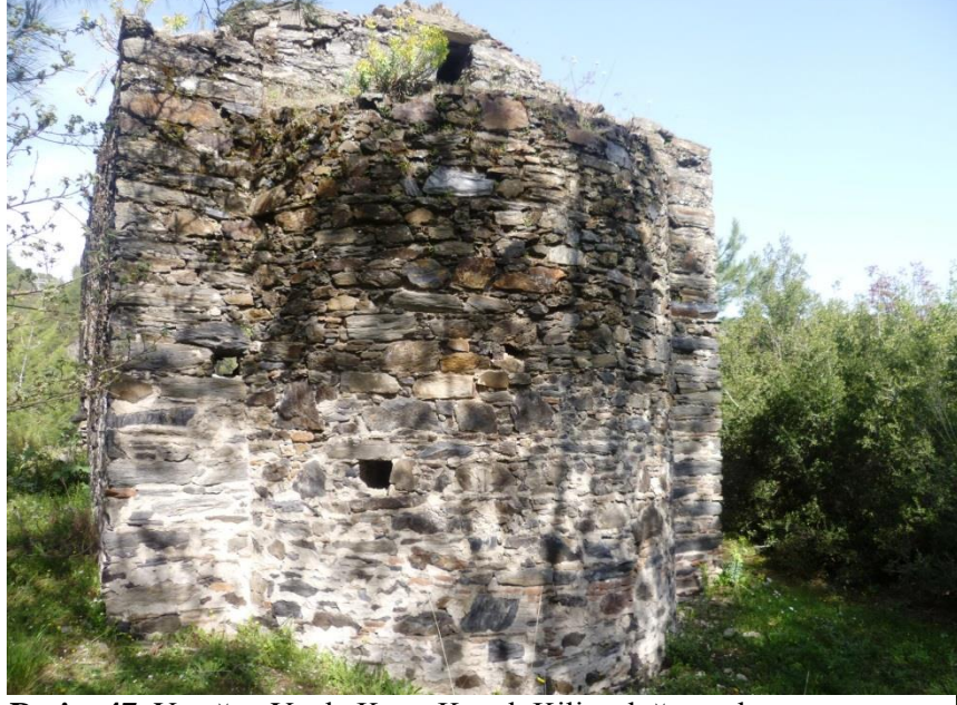
Resim 47. Yatađan Yayla Köyü Küçük Kilise dođu cephe
