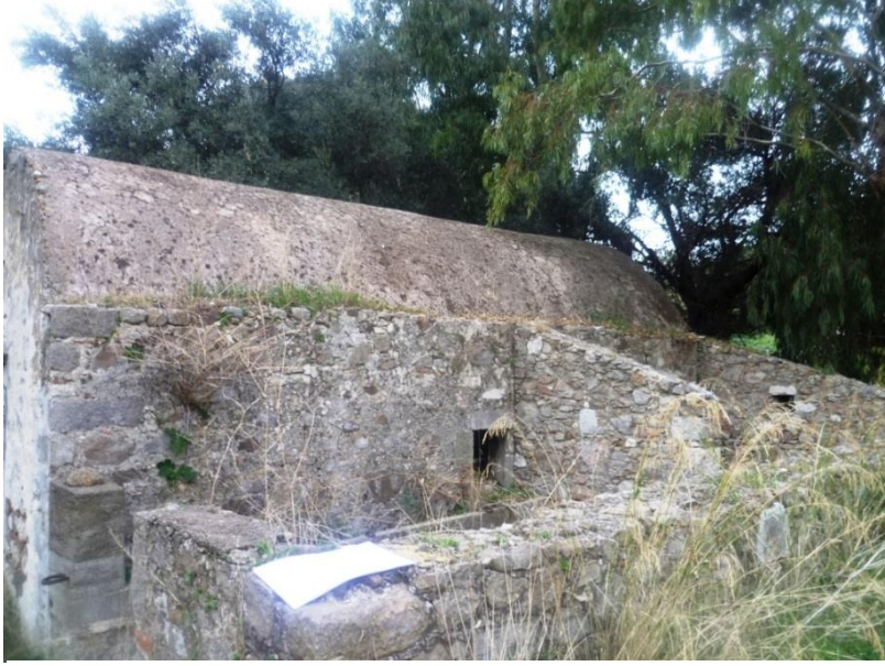
Resim 67. Bodrum Akyarlar Köyü Kilise I güney cephe
