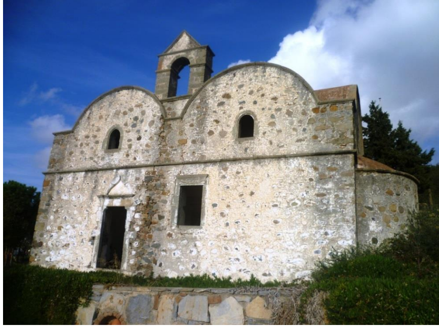
Resim 104. Bodrum Peksimet Köyü Küçük Kilise güney cephe
