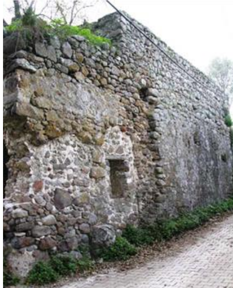
Resim 55. Bodrum Bitez Gara Kilisesi kuzey cephe
