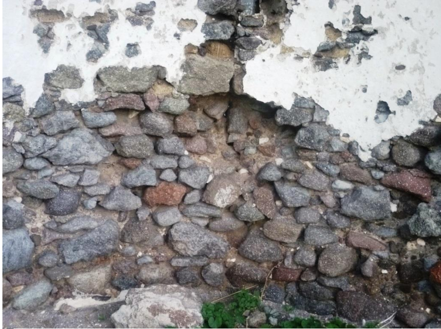
Resim 79. Bodrum Akyarlar Ky Kilise II duvar rgs
