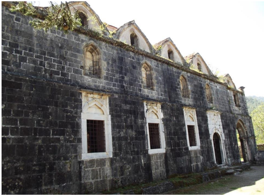
Resim 150. Fethiye Kayaköy Aşağı Kilise kuzey cephe
