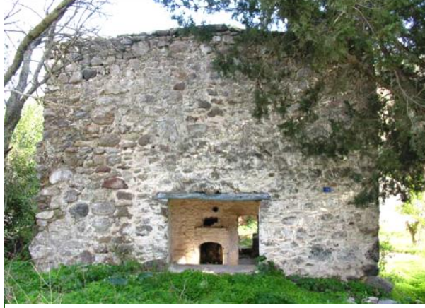
Resim 54. Bodrum Bitez Gara Kilisesi batı cephe
