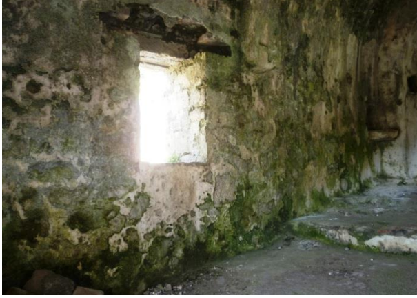
Resim 294. Fethiye Kayaköy Küçük Kilise XV kuzey duvarındaki pencere
