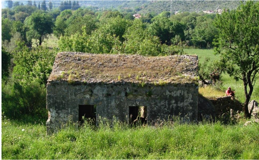
Resim 177. Fethiye Kayaköy Küçük Kilise II güney cephe
