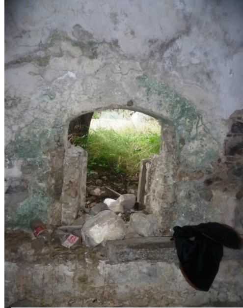
Resim 70. Bodrum Akyarlar Köyü Kilise I pencere detayı
