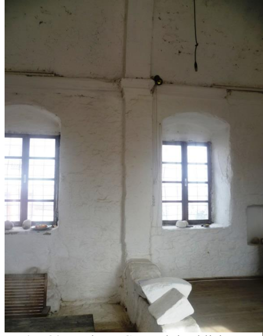
Resim 82. Bodrum Gümüşlük Eklisia Kilisesi naos duvarlarındaki paye detayı
