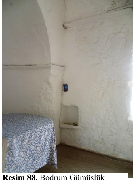
Resim 88. Bodrum Gümüşlük Eklisia Kilisesi apsisin güneyindeki niş
