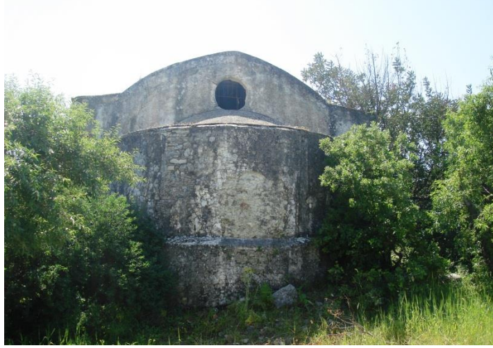
Resim 322. Datça Hızırşah Kilisesi doğu cephe
