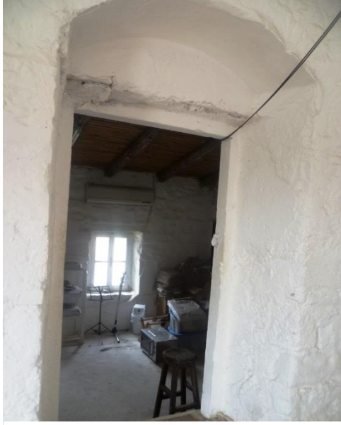
Resim 83. Bodrum Gümüşlük Eklisia Kilisesi naos batı girişi
