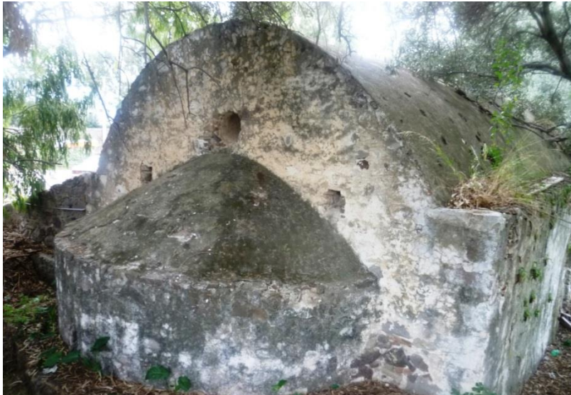
Resim 68. Bodrum Akyarlar Köyü Kilise I doğu cephe
