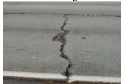
Spalling
