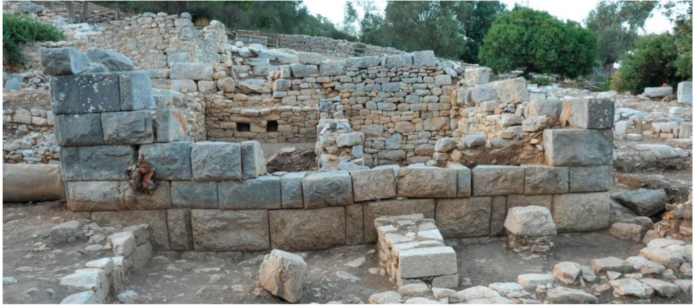
2: Güney Duvar, Dış Cephe Görünümü.
