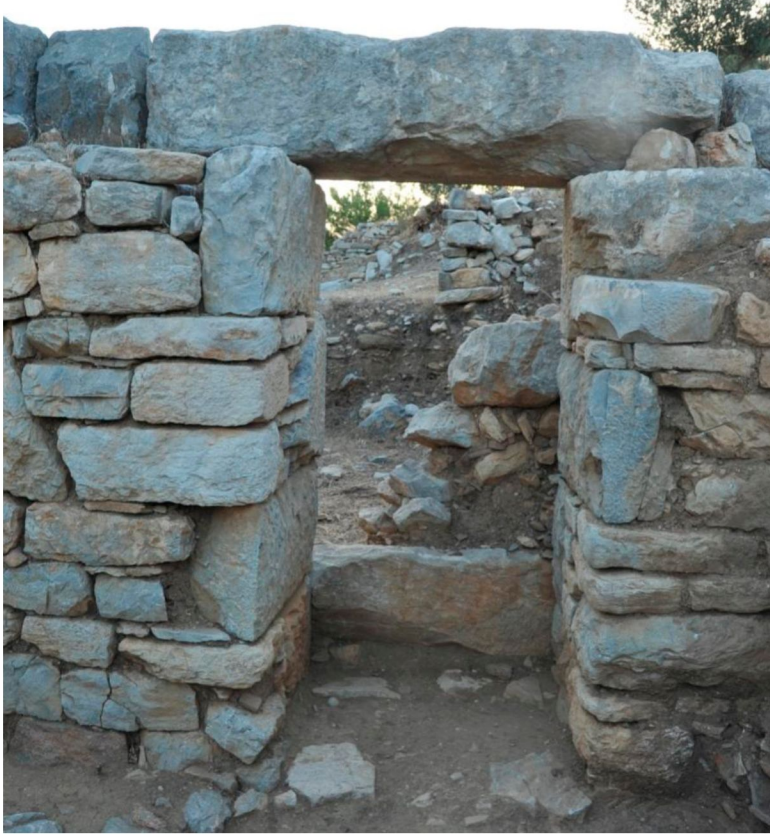
1: Mekan 2, Giriş Kapısının İç Kısmı.
