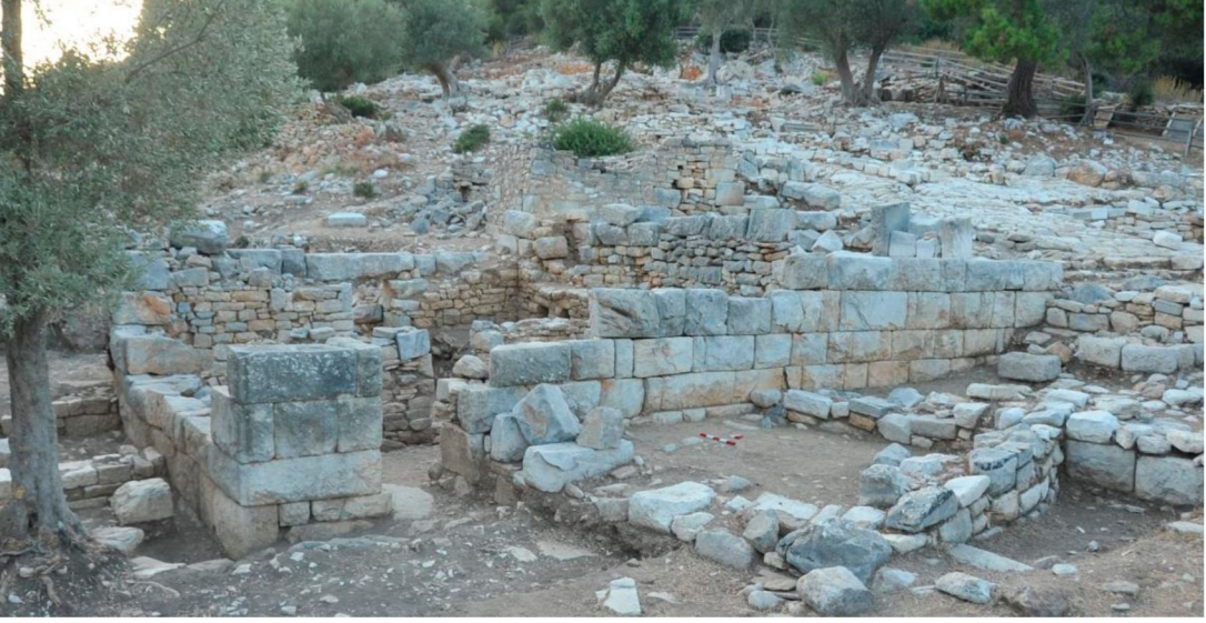
1: Doęu Duvar, Dış Cephe Görünümü.
