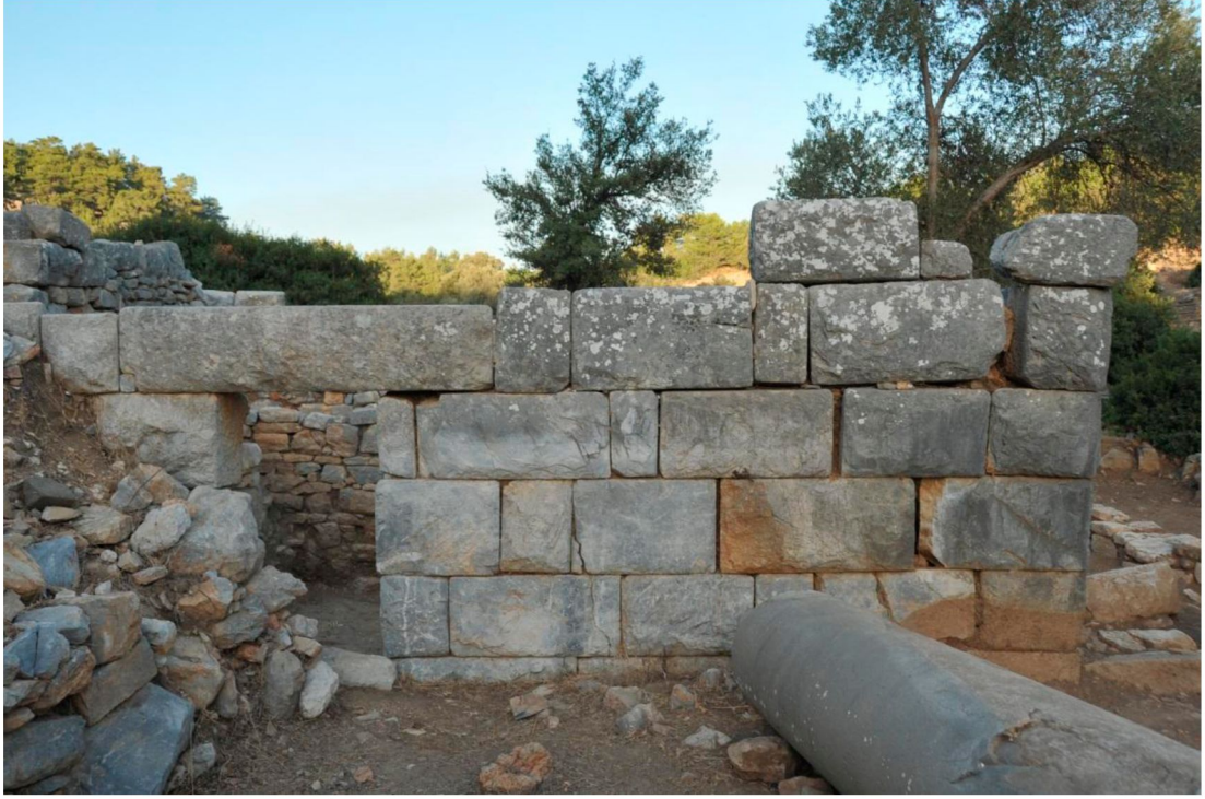
1: Batı Duvar, Dış Cephe Görünümü.
