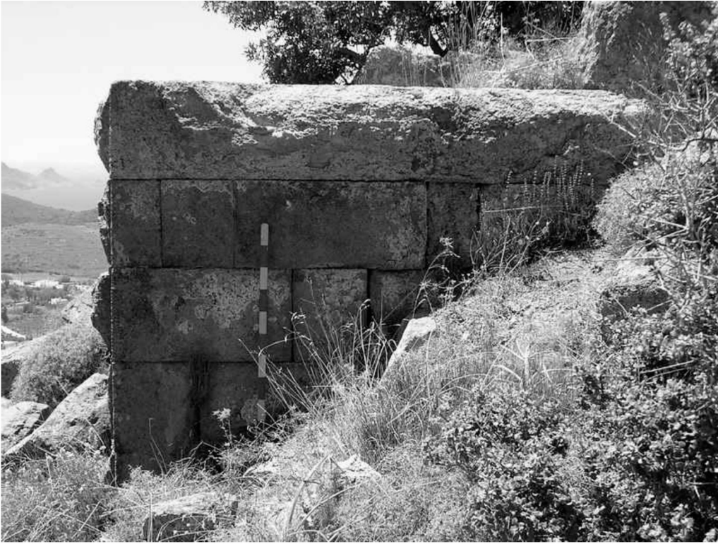
2: Myndos, Kale Tepe'deki güney kulesinin doğu köşesi (Çimen 2004, Lev. 16, Res. 1)
