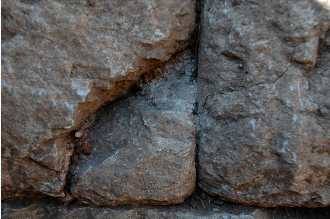
2: Mekan 2, Geç Dönem Onarım Harç İzleri.
