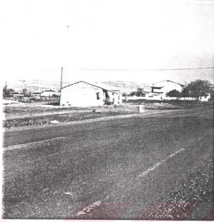
Foto 22: Cip Köyündeki değirmen.
