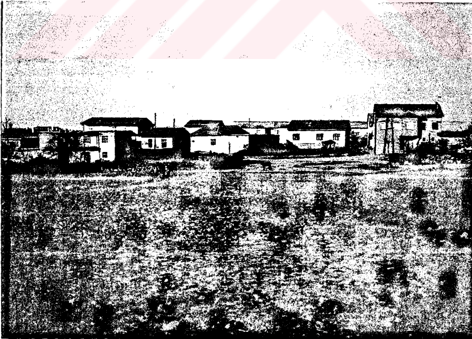
Foto 4: Cip köyünde, konutların bir kısmının toplu görünüşü.
