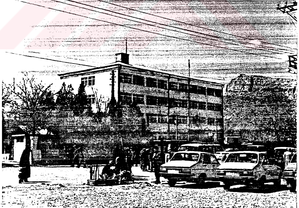
Resim 13: Bünyesinde adliye, ilçe ziraat müdürlüğü, tapu ve kadastro, nüfus müdürlüğü ve kaymakamlık gibi resmi kurumları barındıran Çermik Hükümet konağının görünüşü.
