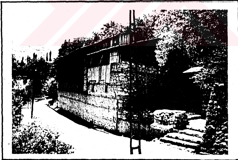
Foto: 4.14 Kemalije'de eğim nedeniyle tek katlı konutlarda bile iki katlı konuta harcanan malzeme kullanılmaktadır. Temel taş , birinci kat ahşap malzeme kullanılmıştır.
