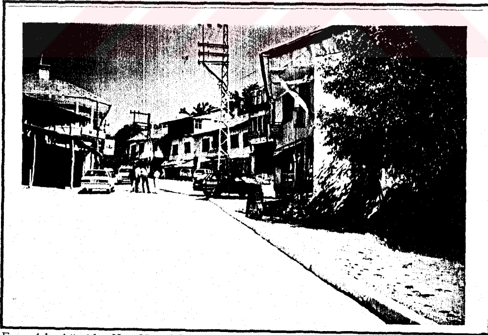
Foto: 4.1 Ağın'da Hacı Yusuf Cami çevresinde ikinci gelişen ticari nüve ve Arapkir yolu burada Konut + işyeri düzeni hakimdir.
