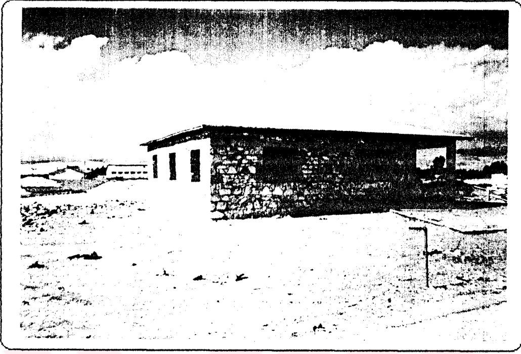
Foto 2.7. Taştan İnşaa Edilmiş Mesken: Muratçık köyü yakınlarında son dönem artan taş yapılardan birisi
