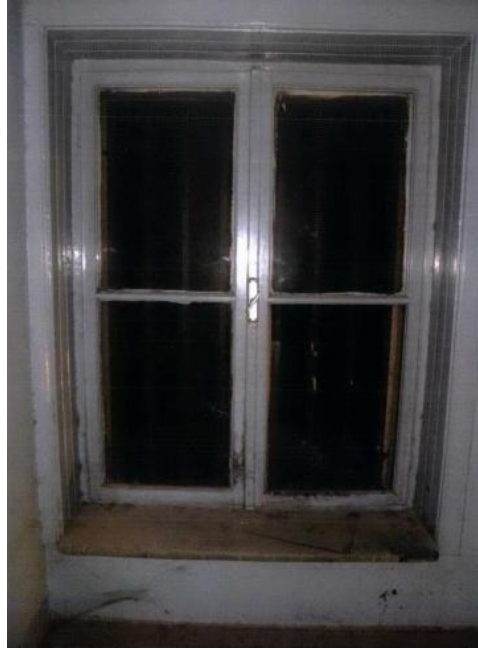
Şekil 4.40 Binada Kullanılan Özgün Ahşap Pencere Görünümü
