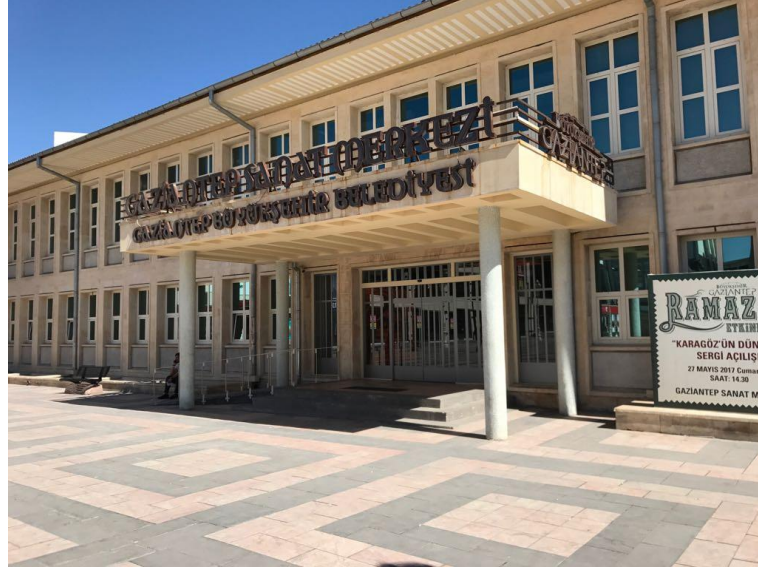
Şekil 4.21 A Blok Kuzey Cephesi Giriş Saçağı
