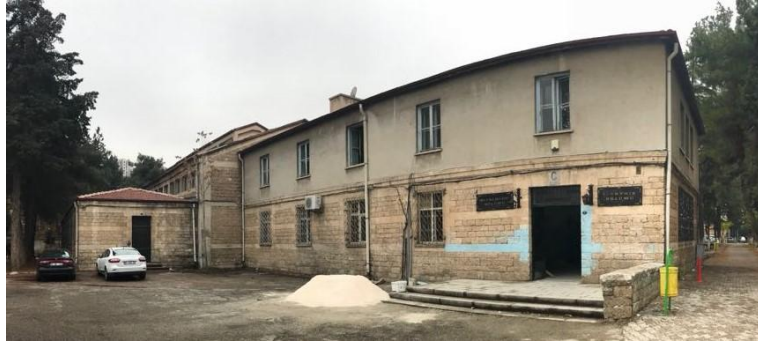
Şekil 4.191 C Blok Güneydoğu Cephesindeki Giriş
