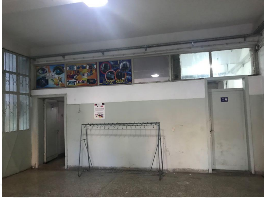
Şekil 4.217 D Blok Giriş Holünden Görüntü (Sacır, 2017)
