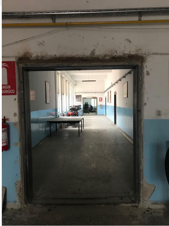
Şekil 4.225 F Bloğa Ait Koridorun Görünümü (Sacır, 2017)
