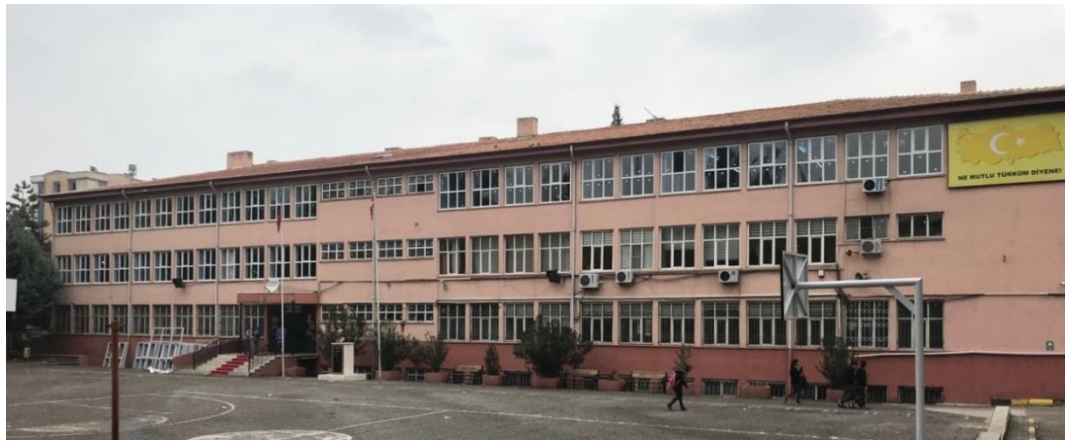
Şekil 4.208 A Blok Güney Cephesi
