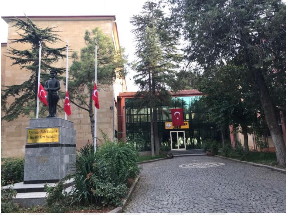
Şekil 4.158 Gaziantep Lisesi'nin Kuzeydoğu Cephesi Derslik ve Geçit Blokları Fotoğrafı (Sacır, 2017)
