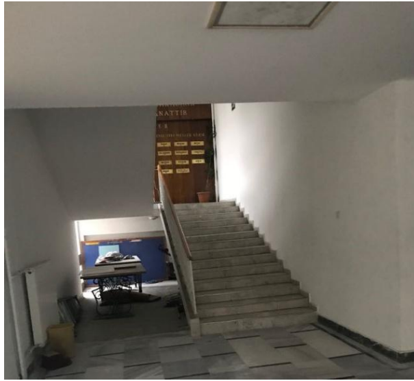
Şekil 4.210 A Blok Kuzey Cephedeki Giriş Holünden Merdivenin Görünümü
