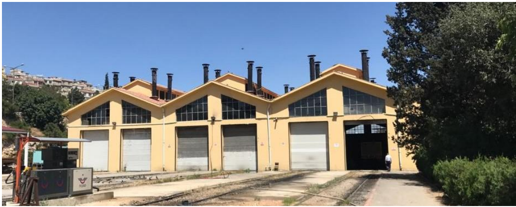
Şekil 4.87 Lokomotif Deposu Ön Cephe
