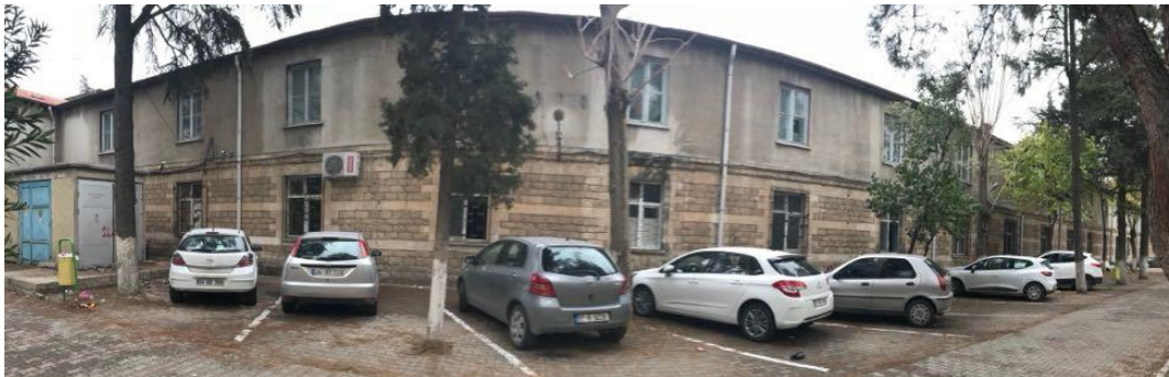
Şekil 4.193 C Blok Kuzeydoğu Cephesi
