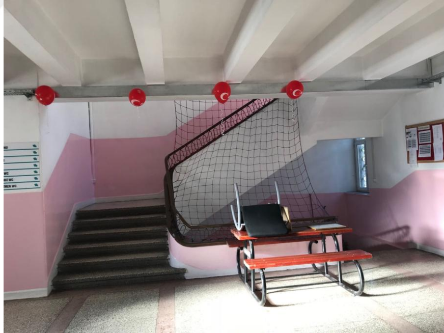
Şekil 4.142 Giriş Holünden Merdivenin Görünümü (Sacır, 2017)
