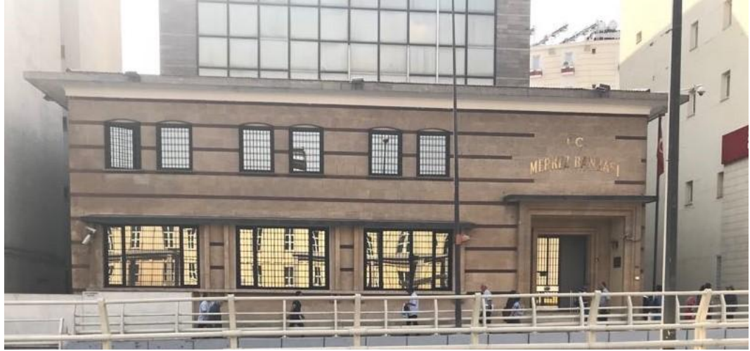
Şekil 4.105 Gaziantep Merkez Bankası Doğu Cepheden Fotoğraf (Sacır, 2017)
