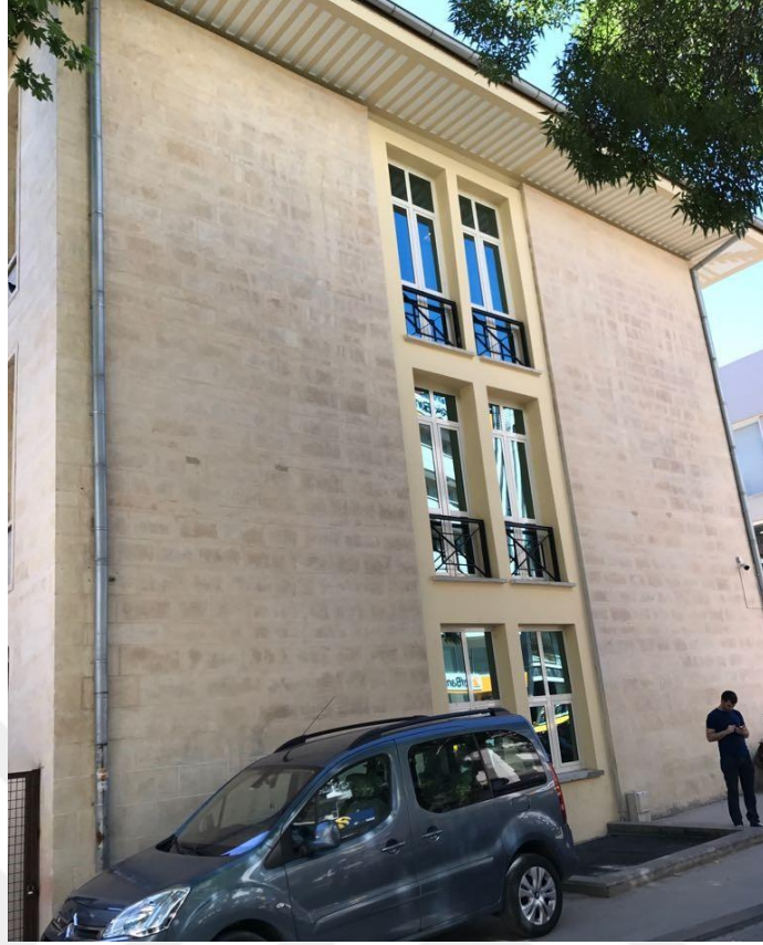
Şekil 4.27 A Blok Dr. Mecit Barlas Caddesi Cephesi
