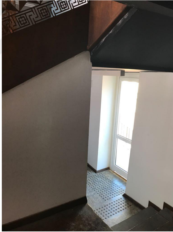
Şekil 4.44 Günümüzde Merdiven Arkasındaki Avluya Açılan Kapı (Sacır, 2017)
