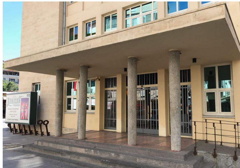
Şekil 4.36 C Blok Giriş Saçağı
