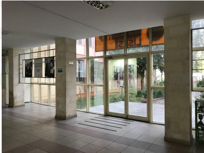
Şekil 4.169 Giriş Kapısının İçerden Görünüşü (Sacır, 2017)
