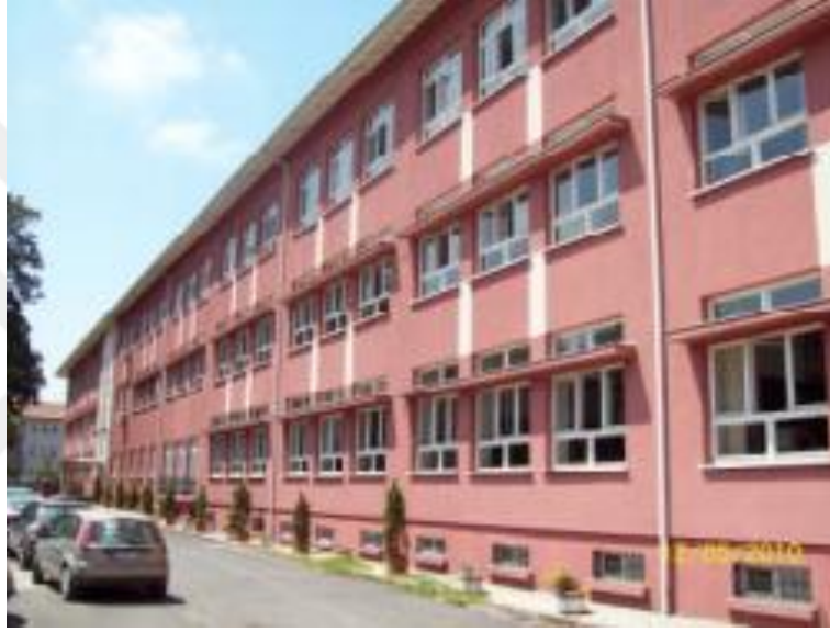
Şekil 4.120 Trabzon Lisesi Ön Cephe
