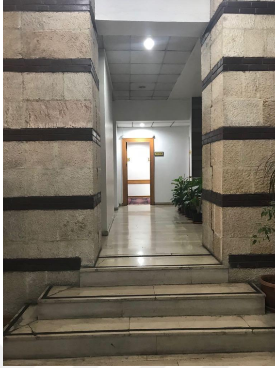
Şekil 4.117 Gaziantep Merkez Bankası İlave Binadan Eski Binaya Merdivenle Geçiş
