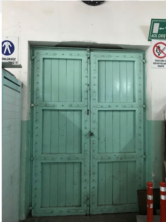
Şekil 4.202 Makine Atölyesi Ahşap Çıkış Kapısı (Sacır, 2017)
