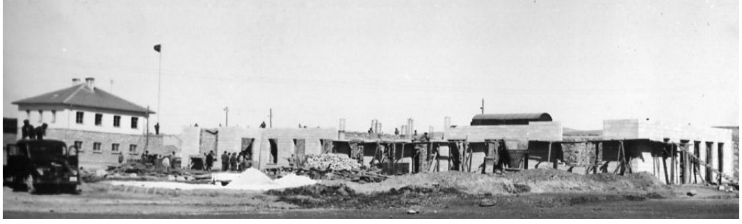
Şekil 4.82 Gaziantep Gar Binası İnşaatından Bir Fotoğraf (Sıtkı Severoğlu arşivinden)
