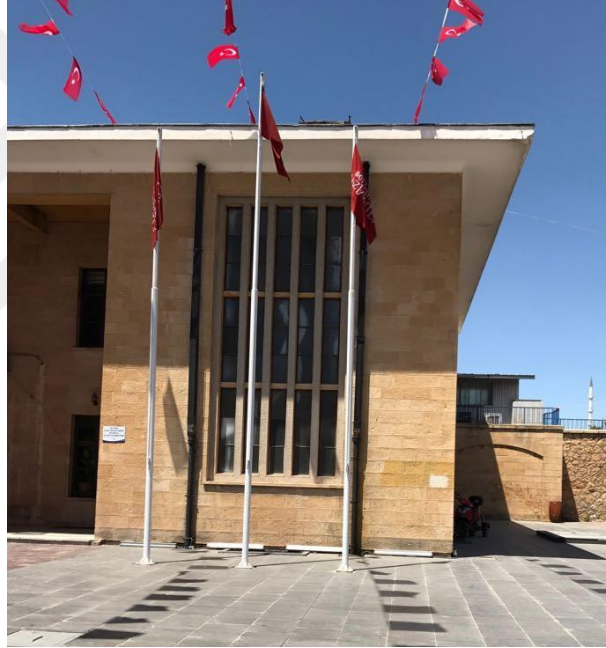
Şekil 4.67 Ön Cephe Merdiven Bölümü (Sacır, 2017)
