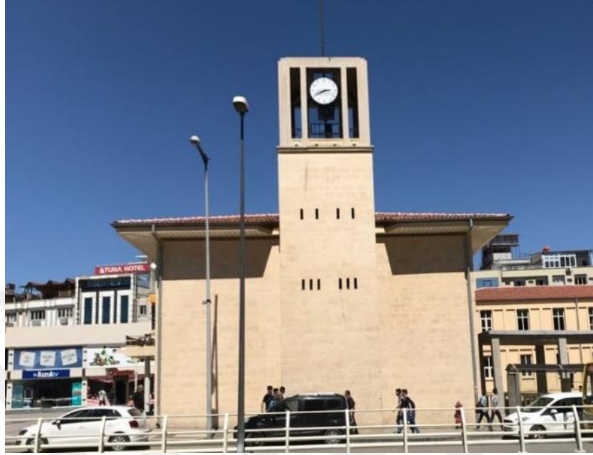
řekil 4.26 A Blok Hürriyet Caddesi Cephesi
