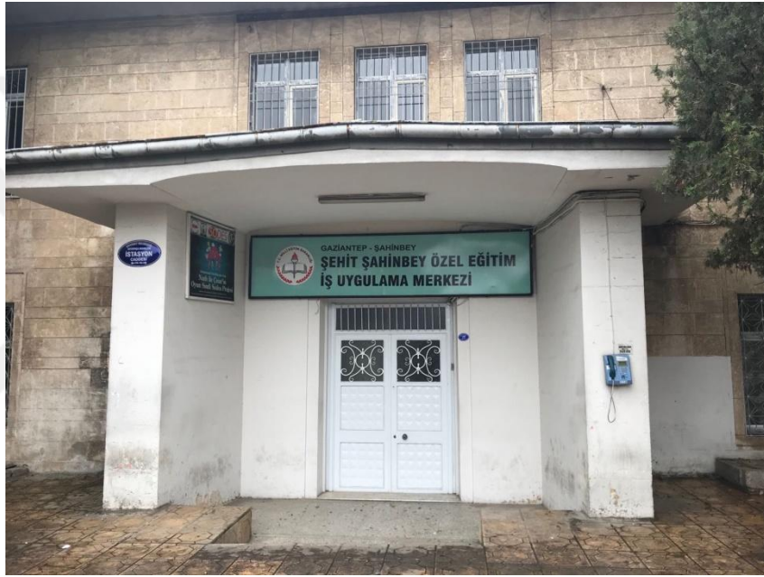
Şekil 4.131 Gaziantep Ticaret Lisesi İstasyon Caddesi'nden Giriş Kapısı (Sacır, 2017)
