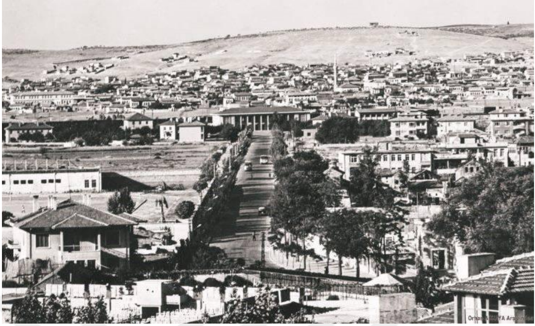
Şekil 4.57 İstasyon Caddesi'nden Gar Binasının Görünümü
