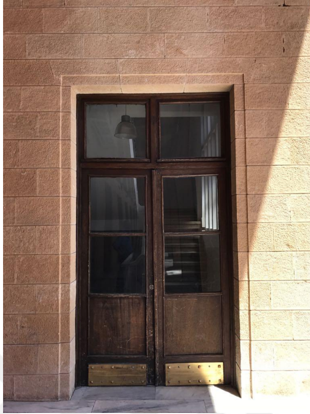
Şekil 4.68 Merdivene Giriş Kapısı (Sacır, 2017)
