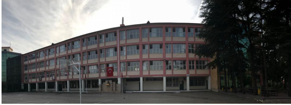
Şekil 4.162 Gaziantep Lisesi Okul Bahçesinden Derslik Bloğunun Fotoğrafi (Sacır, 2017)
