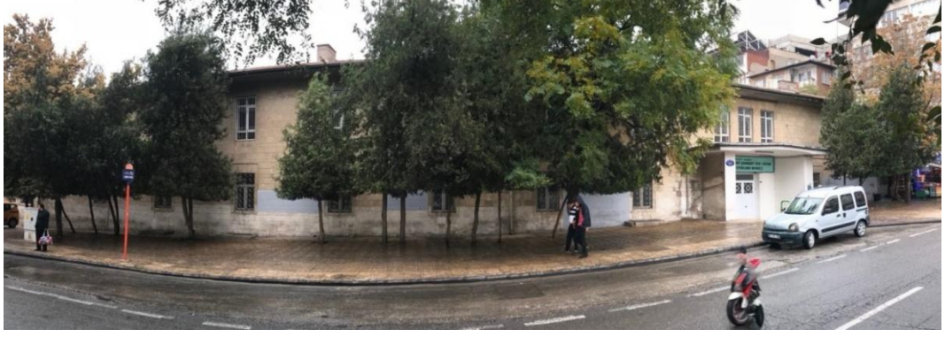
Şekil 4.130 Gaziantep Ticaret Lisesi Kuzey Cephesi (Sacır, 2017)
