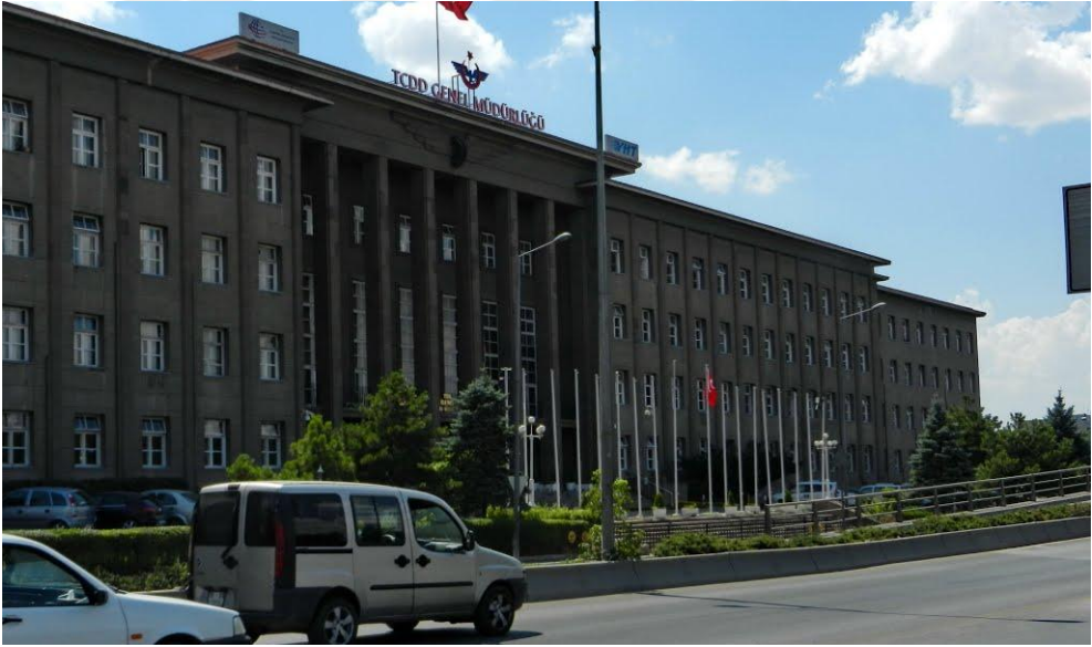
Şekil 3.12 Devlet Demir Yolları Genel Müdürlük Binası, Ankara.
