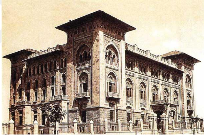
Şekil 4.95 Ziraat Bankası Binası, Ankara.
