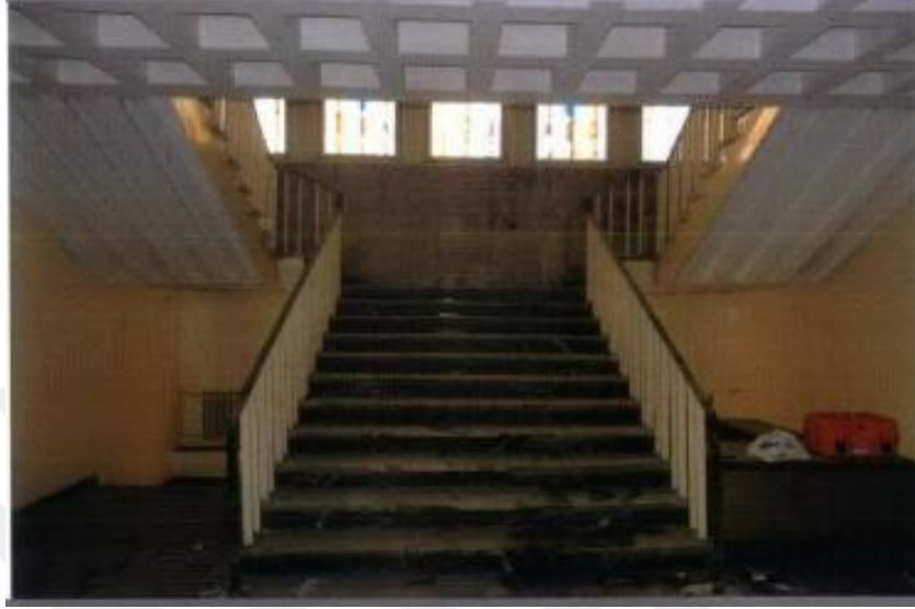
Şekil 4.41 A Blok Girişin Karşısındaki Merdiven
