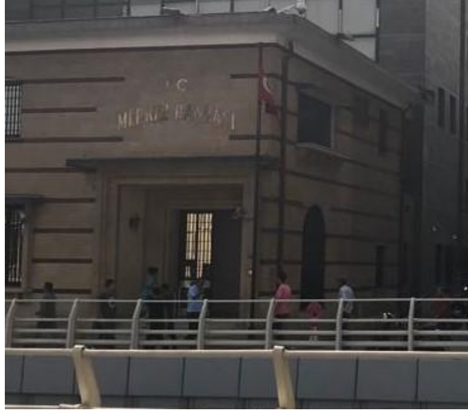
Şekil 4.110 Gaziantep Merkez Bankası Kuzey Cephesi Fotoğrafi
