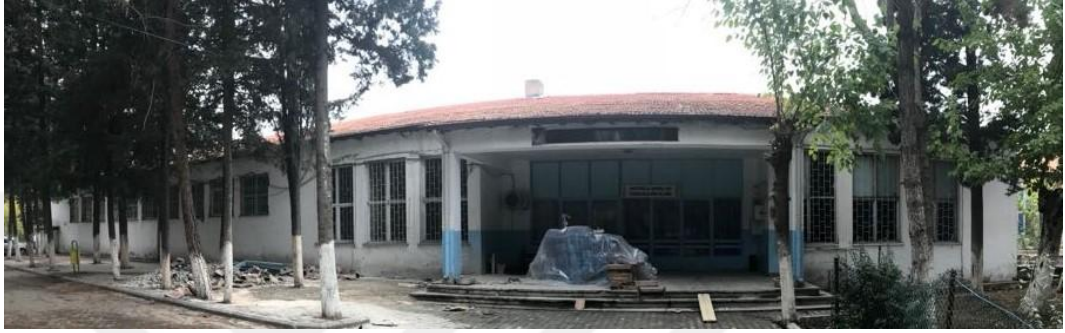
Şekil 4.219 F Blok Girişi
