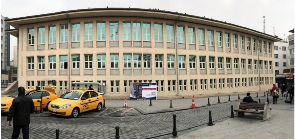
Şekil 4.37 C Blok Balıklı Parkı Cephesi
