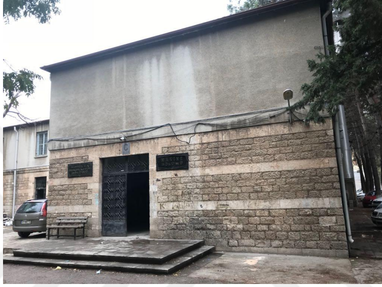
Şekil 4.190 C Blok Kuzeydoğu Cephesi Giriş
