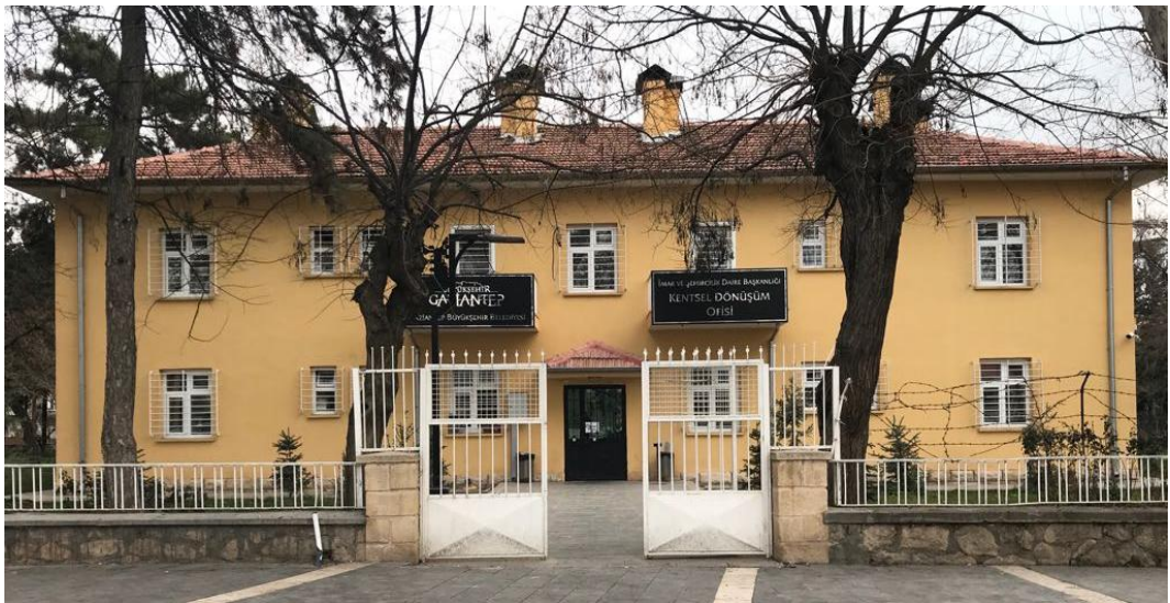
Şekil 4. 91 Gar Binasının Karşısında Kentsel Dönüşüm Ofisi Olarak Kullanılan Lojman Binası
