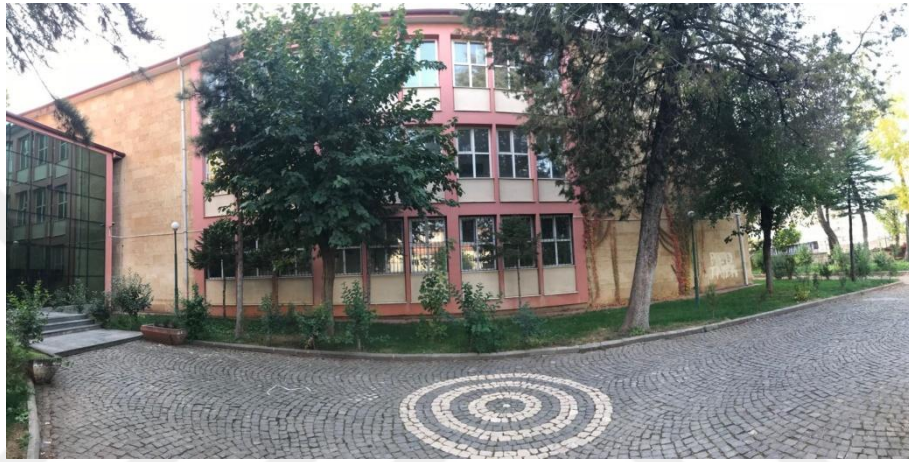
Şekil 4.163 Gaziantep Lisesi, İdari Blok Güneydoğu Cephesine Yansıyan Bölüm Fotoğrafi (Sacır, 2017)
