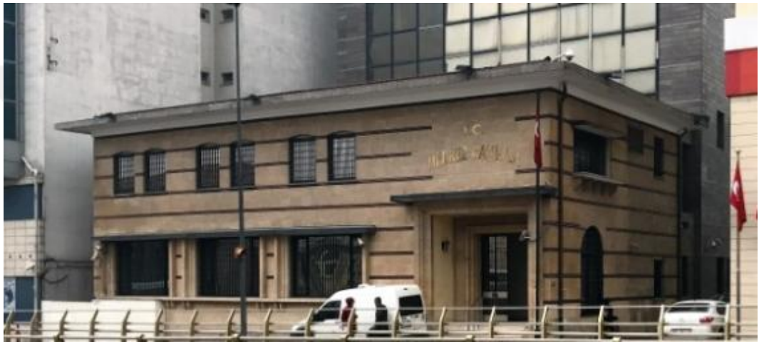
Şekil 5.3 Gaziantep Merkez Bankası Binası
