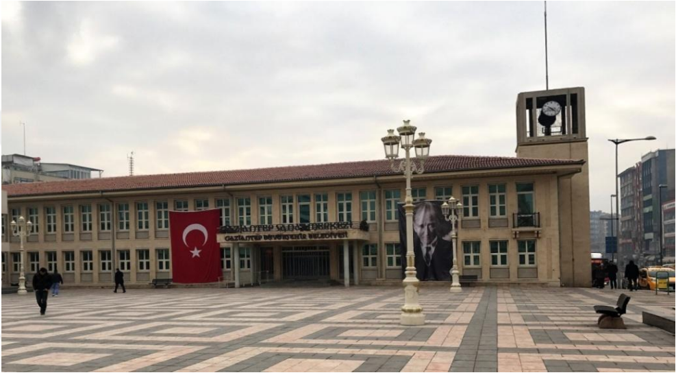
Şekil 4.19 A Blok Kuzey Cephesi
