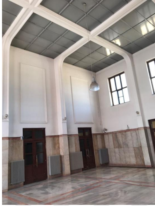
Şekil 4.79 Kolon ve Kirişlerin Birleşimi (Sacır, 2017)
