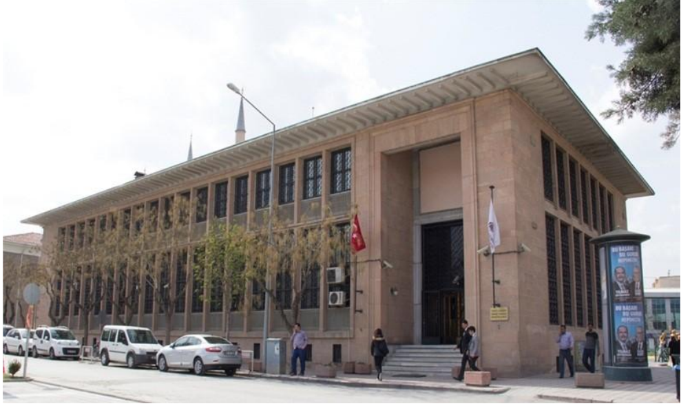
Şekil 4.98 Eskişehir Merkez Bankası Binası Ön Cephe ( http://www.eskisehirkulturenvanteri.gov.tr/anitdetay.aspx?ID=379 )
