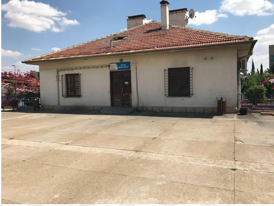
Şekil 4.84 Vagon Servis Şefliği Binası Arka (Kuzey) Cephe (Sacır, 2017)
