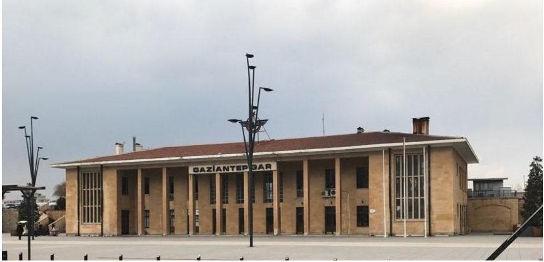
Şekil 4.66 Gaziantep Gar Binası Ön Cephe (Sacır, 2017)
