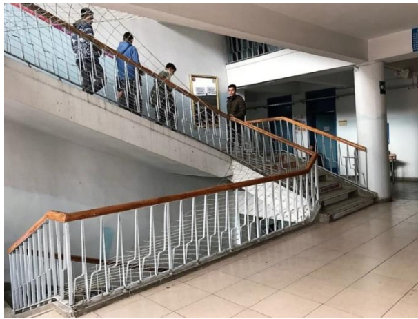
Şekil 4.213 A Blok Güney Cephe Giriş Holü
