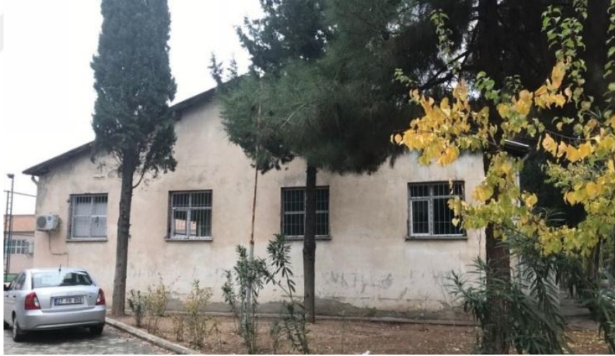
Şekil 4.220 F Blok Güneybatı Cephesi
