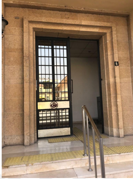
Şekil 4.108 Gaziantep Merkez Bankası Giriş Kapısı Detayı (Sacır, 2017)
