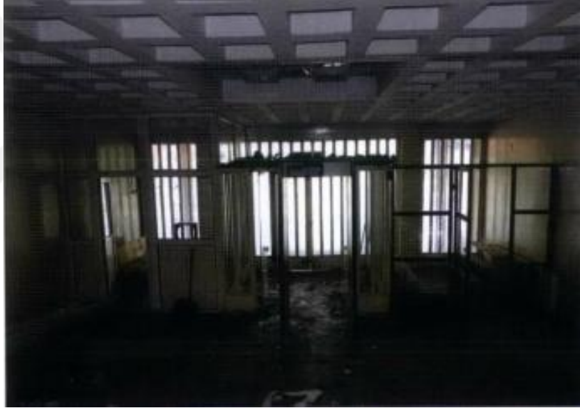
Şekil 4.46 A Blok Girişin İçeriden Görünüşü
