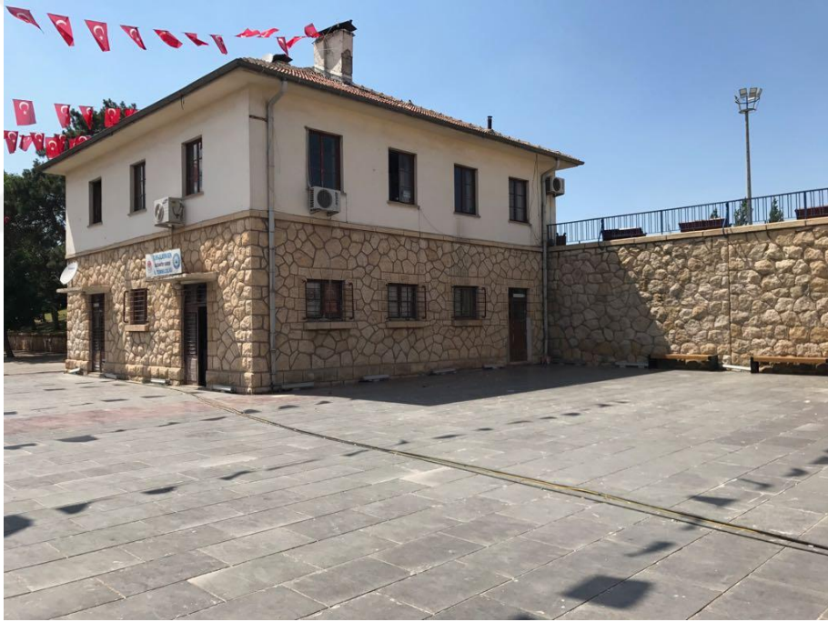
Şekil 4.83 İstasyon Meydanı'ndan Vagon Servis Şefliği Binası Görünüşü (Sacır, 2017)
