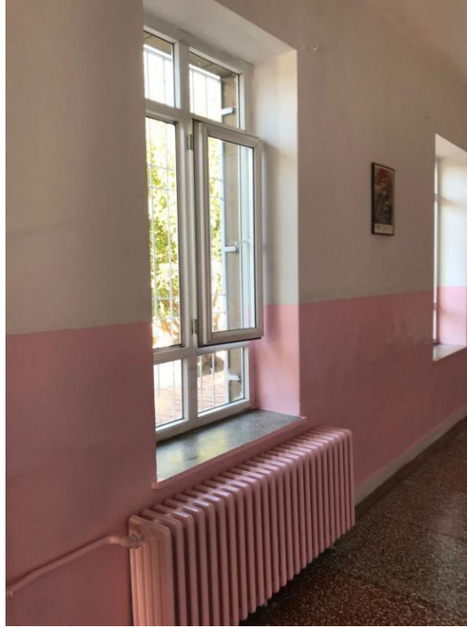
Şekil 4.148 PVC Olarak Yenilenmiş Pencere (Sacır, 2017)
