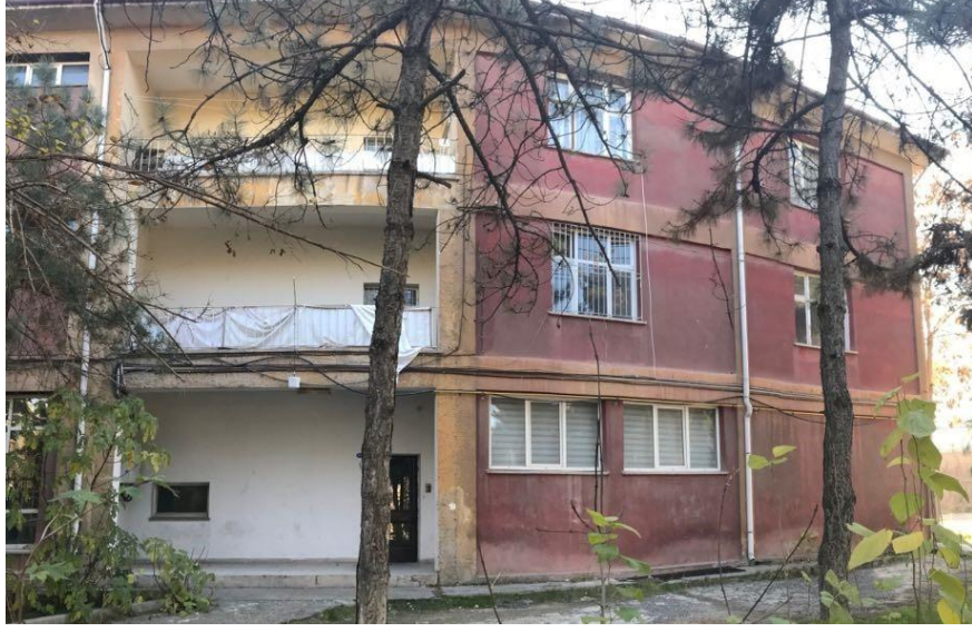
Şekil 4.215 D Blok Lojman Bölümü (Sacır, 2017)
