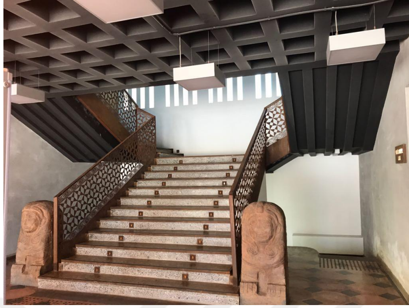
Şekil 4.43 Günümüzde A Blok Merdiven (Sacır, 2017)
