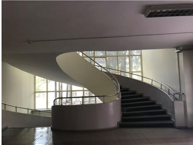
Şekil 4.171 Derslik Bloğu Yarım Döner Merdiven
