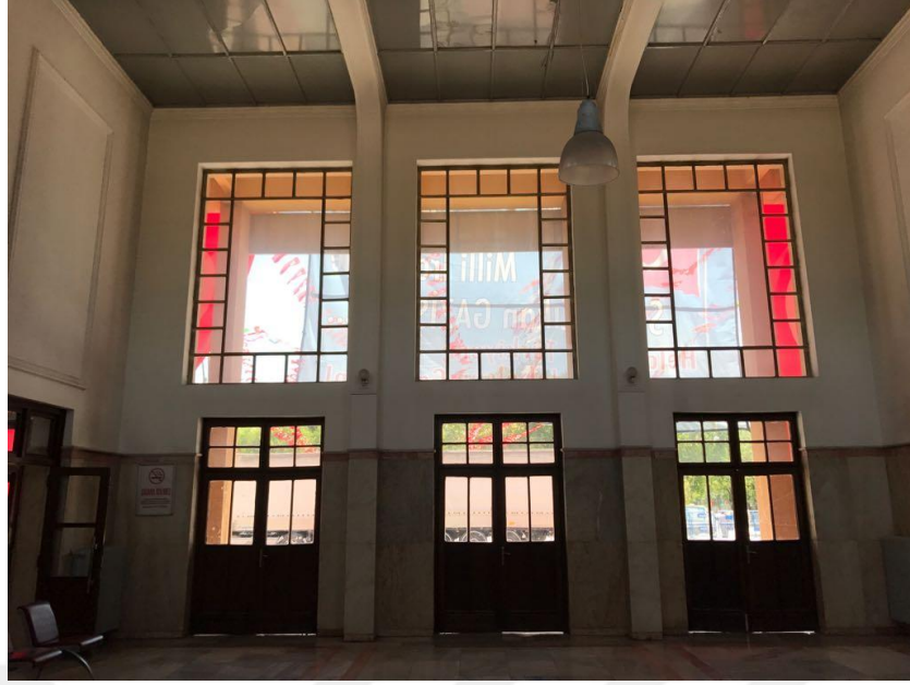
Şekil 4.76 Hol Giriş Kapılarının İçten Görünüşü (Sacır, 2017)
