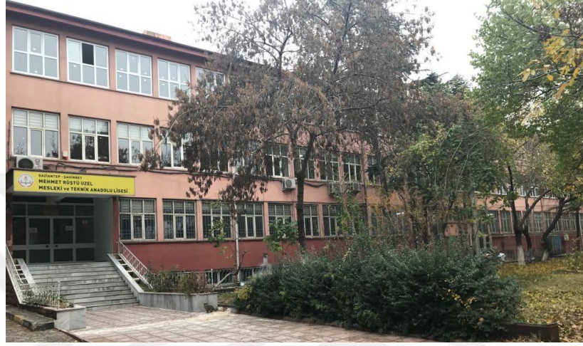
Şekil 4.207 C Blok Kuzey Cephesi
