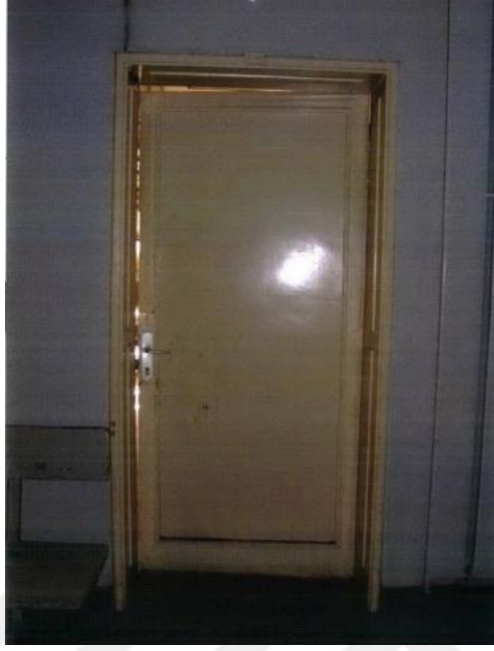
Şekil 4.39 Bina İçindeki Ahşap Kapı Görünümü
