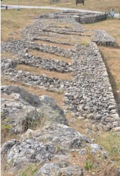
Resim 63: Taş temel –sandık duvar tekniği(Yazarın fotoğraf arşivinden alınmıştır,2015.)
