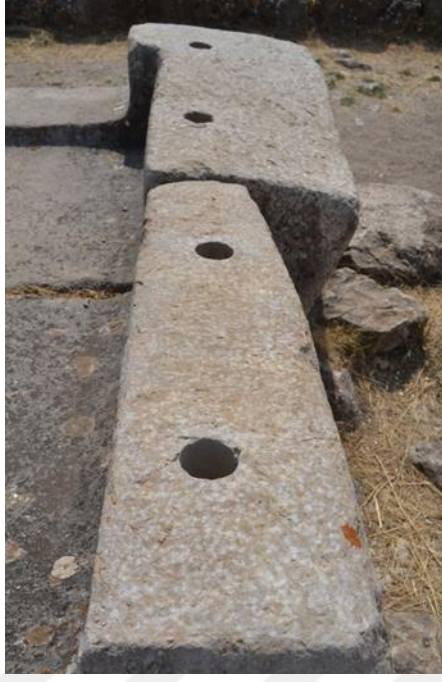
Resim 84: Taşlardaki zıvana delikleri (Yazarın fotoğraf arşivinden alınmıştır, 2015)
