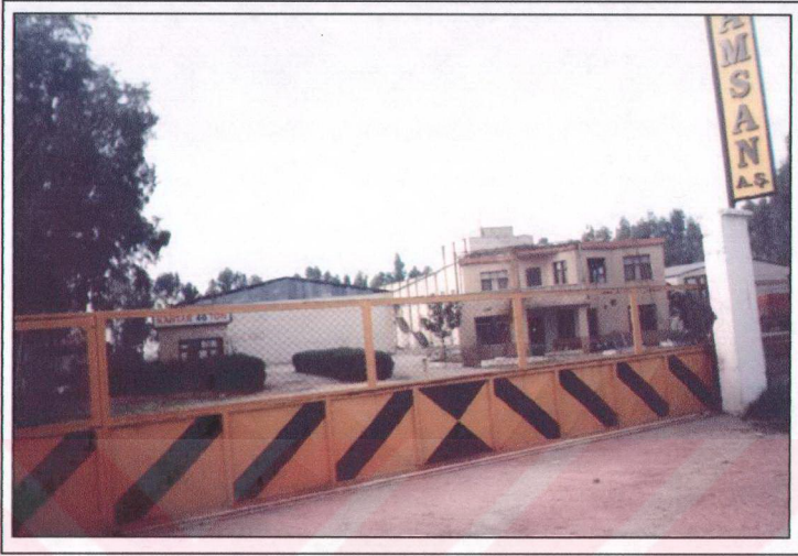
Foto 3.36. 1984 yılında kütlü pamuk çırcırlama amacıyla kurulan Pamsan Çırcır Fabrikası, 1990'lı yıllardan itibaren bu işlevini sürdürmemiş ve 1995 yılında kapanmıştır. Bu yıldan sonra ise fabrikaya mısır kurutma tesisi ilave edilmiştir ve hala bu amaçla çalışmaktadır (2001).
