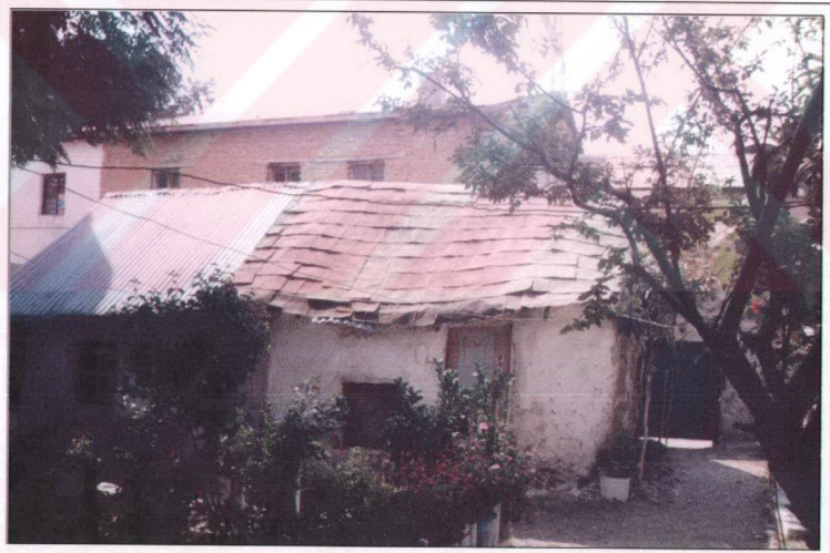
Foto 3.18. Pazar mahallesinde yer alan “Huğ” evlerden bir görünüm. Tek odalı olarak inşa edilen ve üzeri saz, karni vs. ile kapatılan bu meskenler, günümüzde yağmurun etkisinden korunmak ve dayanıklılığını artırmak için sac ve teneke parçalarıyla kapatılmaktadırlar (2001).
