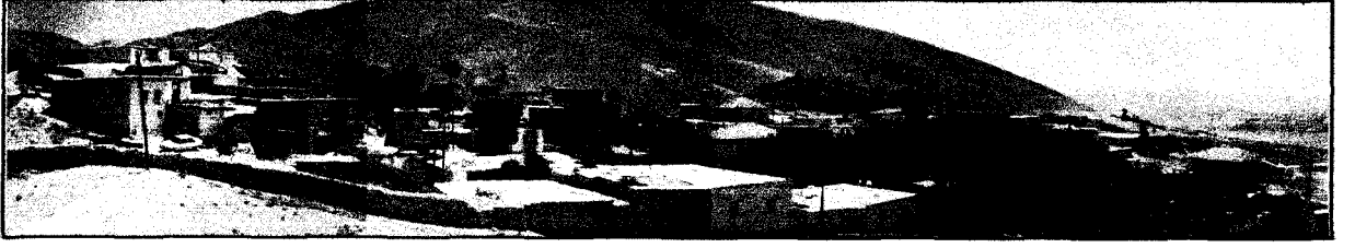
Foto: 29. Genellikle temeli taş ve duvarları kerpiçten yapılmış, düz damlı evlerden oluşan Konacık köyü. Bu düz damlar aynı zamanda ev endüstrisinin yapıldığı faaliyet alanlarıdır.
