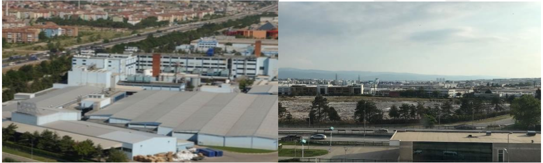
Sifaş Polylen'in yıkılmadan önceki ve sonraki fotoğrafları
