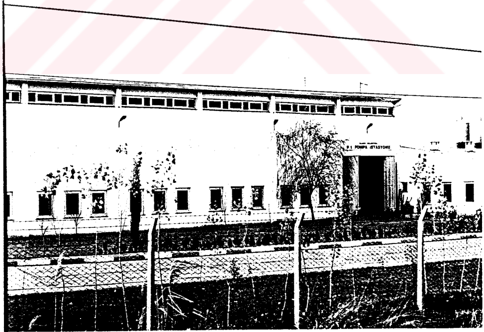
Foto 26 : Elazığ Belediyesine ait P1 Pompa İstasyonu
