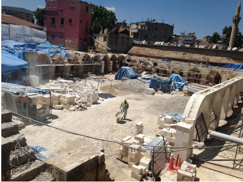
Şekil 4.93 Mecidiye Hanı avlu görünümü: güneydoğu ve güney kanatlarında devam eden restorasyon çalışmaları (Zincircioğlu, 2018)
