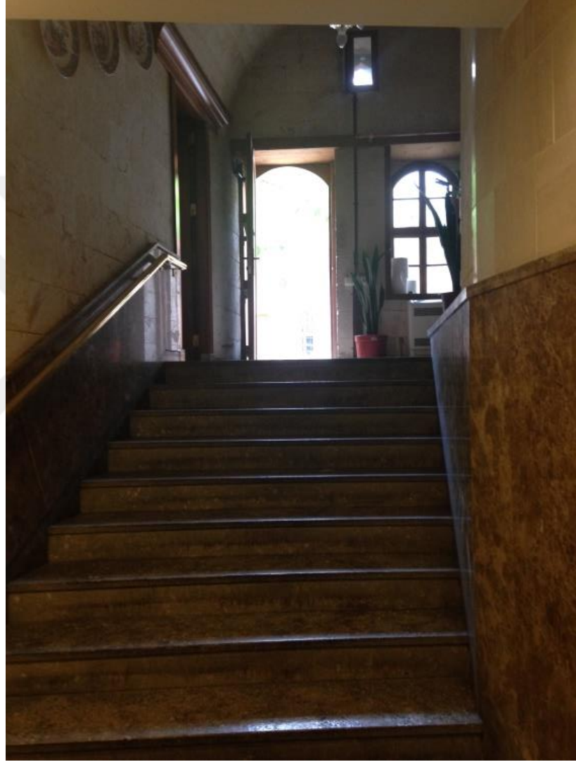
Şekil 4.75 İmam Çağdaş Restoranı'ndan Yüzükçü Hanı'na geçilen mekan (Zincircioğlu, 2018)
