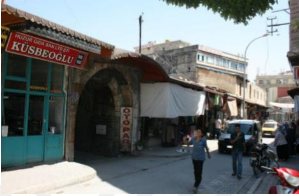
Şekil 4.90 Mecidiye Hanı doğu yönünde bulunan Şehitler Caddesi cephesindeki girişi (Altın, 2015)
