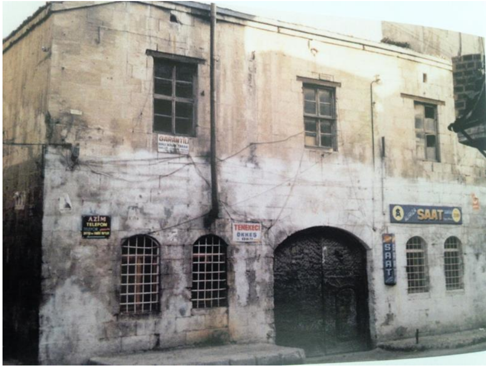
Şekil 4.156 Gümrük Han yenileme öncesi ön cephe (Çam, 2006)
