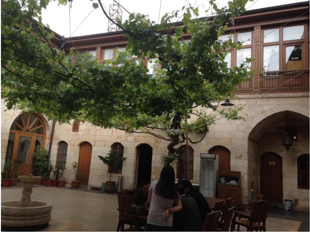
Şekil 4.74 Yüzükçü Hanı avlusunun güney cephesi (Zincircioğlu, 2018)
