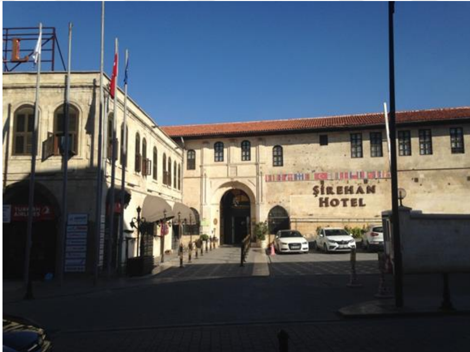
Şekil 4.213 Şirehan kuzey taçkapısı görünüm (Zincirciođlu, 2018)
