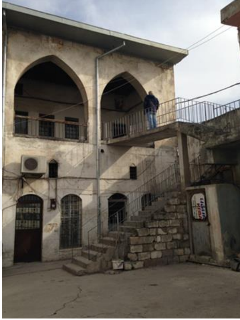
Şekil 4.327 Güven Hanı avludan güney kanadına çıkan sonradan yapılmış betonarme merdiven görünüm (Zincircioğlu, 2017)
