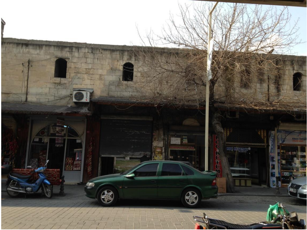
Şekil 4.88 Mecidiye Hanı'nın günümüzde kullanılan giriş batıdaki sokak cephesi (Zincircioğlu, 2017)
