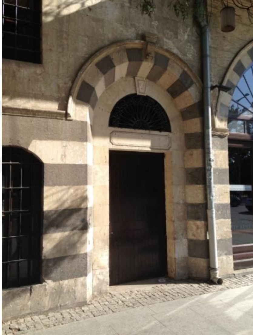
Şekil 4.345 Bayazhan'ın kuzey kanattaki merdivenlerinden birine açılan kapı (Zincircioğlu, 2018)
