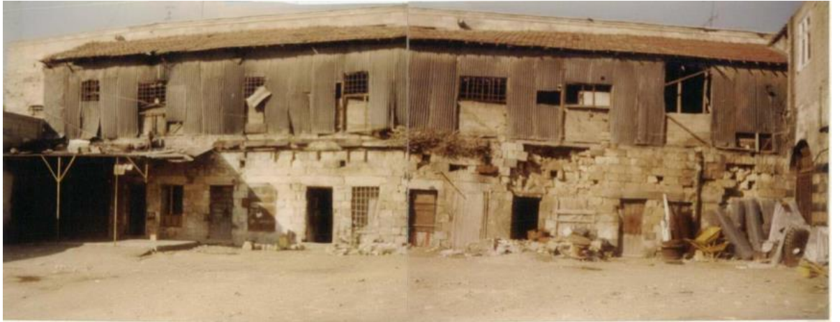
Şekil 4.9 Emirali Hanı batıdaki iki katlı dükkânların görünümü, 1997 (KKarşivi, pdf no 8063)
