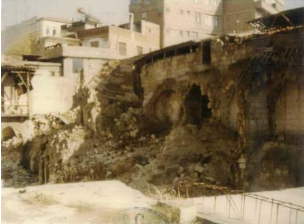
Şekil 4.13 Emirali Hanı rapora konu edilen, doğu kanadın çökmesi durumu, 1997, (KK arşivi, pdf no 1023)
