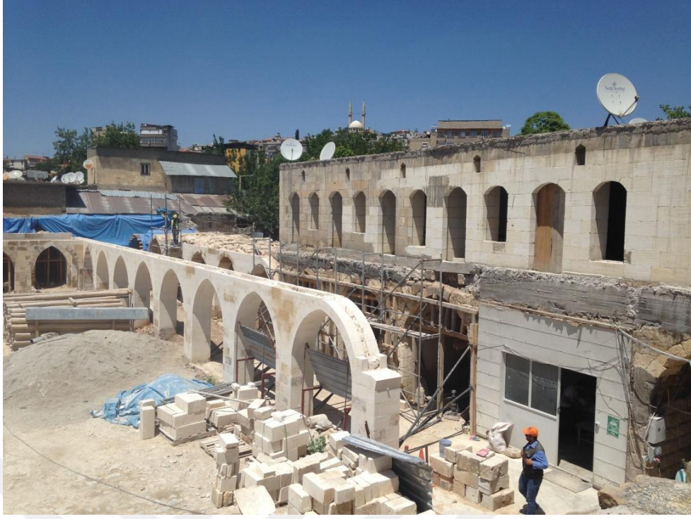
Şekil 4.94 Mecidiye Hanı batı kanadı görünümü; devam eden restorasyon çalışmaları (Zincircioğlu, 2018)
