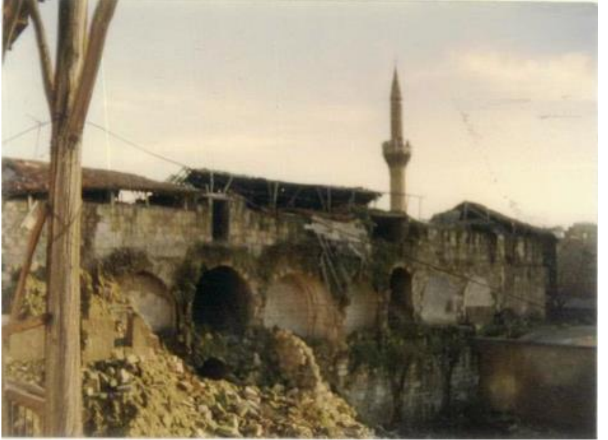
Şekil 4.11 Emirali Hanı doğu cephesi görünümü 1997 (Yetkin, 1997)
