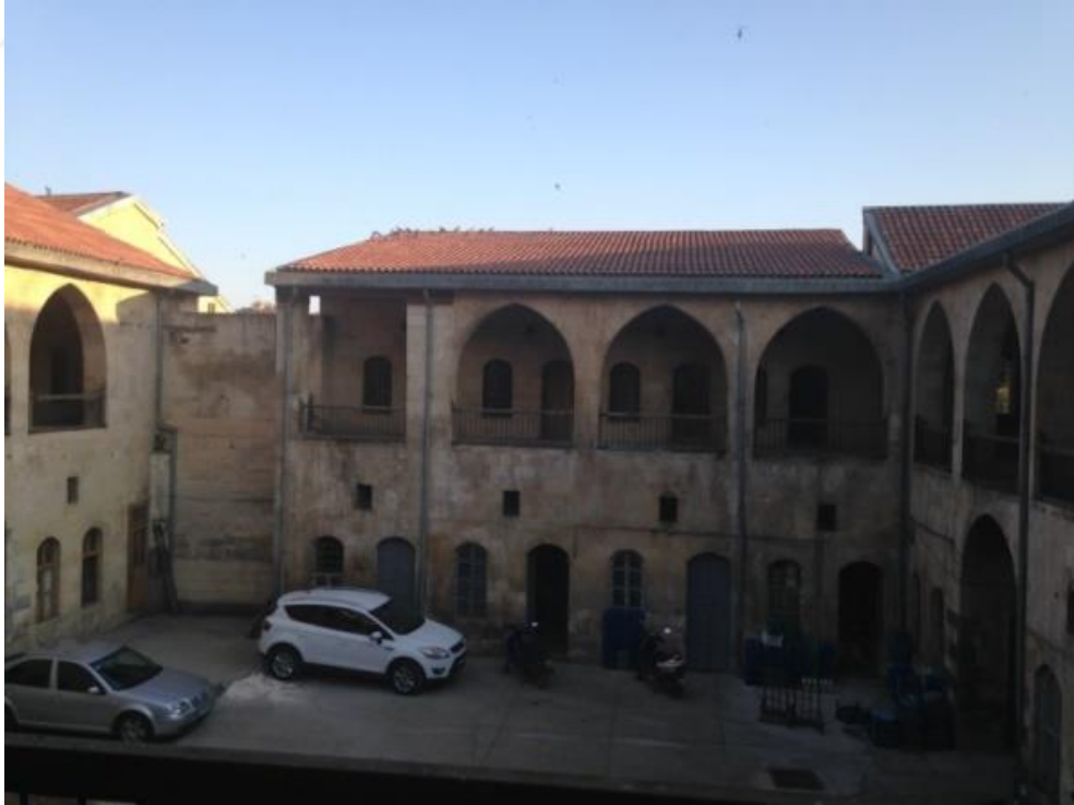
Şekil 4.230 Kırkçü Hanı güney kanadı görünümü (Zincirciođlu, 2018)
