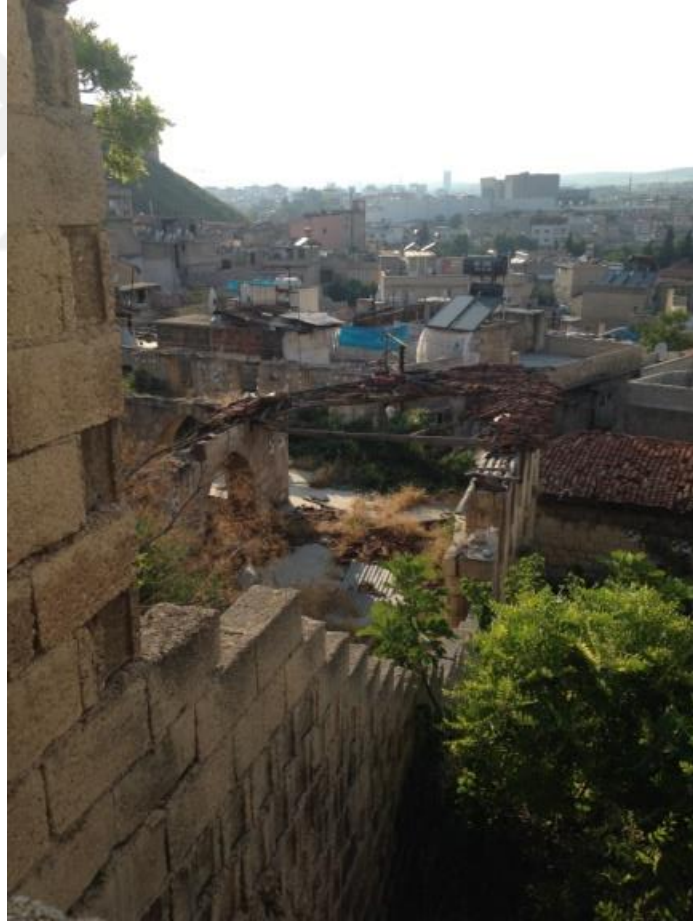
Şekil 4.295 Sabuncu Hanı güney cephesindeki yol kotundan görünümü (Zincircioğlu, 2018)
