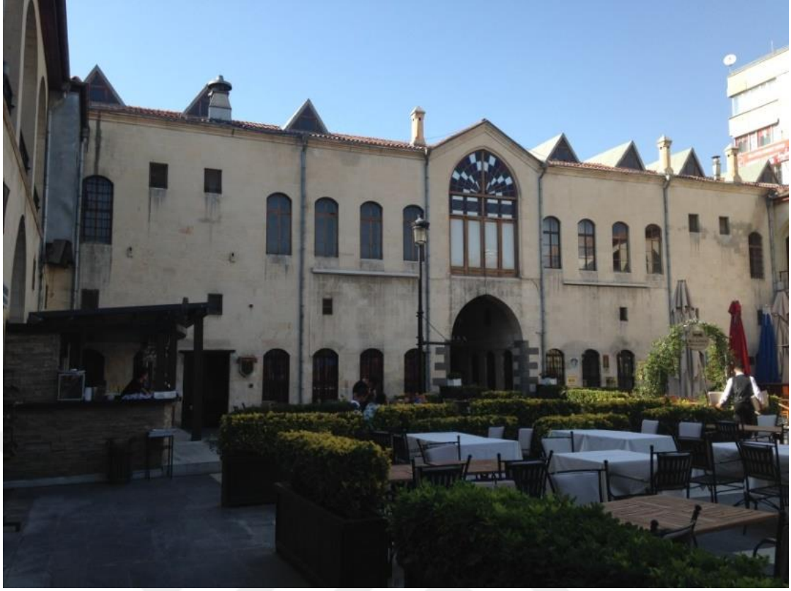
Şekil 4.346 Bayazhan kuzey kanadı (Kent Müzesi) avlu cephesinden görünümü (Zincircioğlu, 2018)
