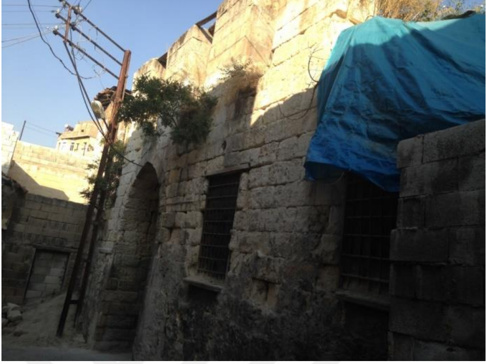
Şekil 4.297 Sabuncu Hanı kuzeydoğu köşedeki giriş cephesi (Zincircioğlu, 2018)
