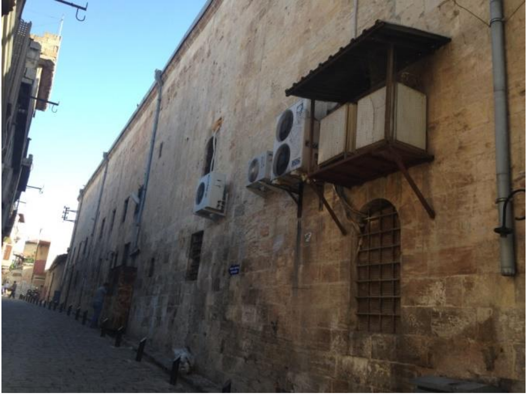
Şekil 4.264 Büdeyri Hanı doğu cephesi (Zincircioğlu, 2018)
