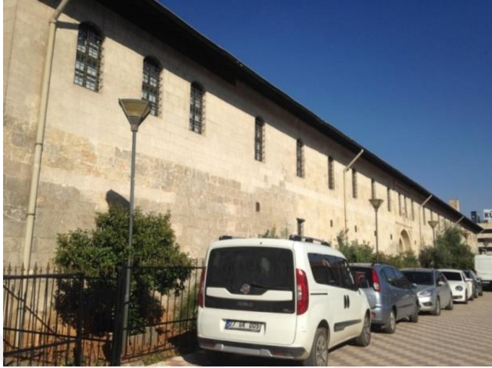
Şekil 4.216 Şirehan batı cephesi (Zincircioğlu, 2018)
