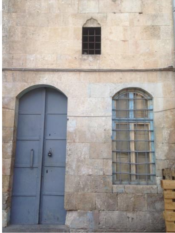
Şekil 4.232 Kırkçü Hanı zemin kat kapı, pencere ve tepe penceresi görünümü (Zincirciođlu, 2018)
