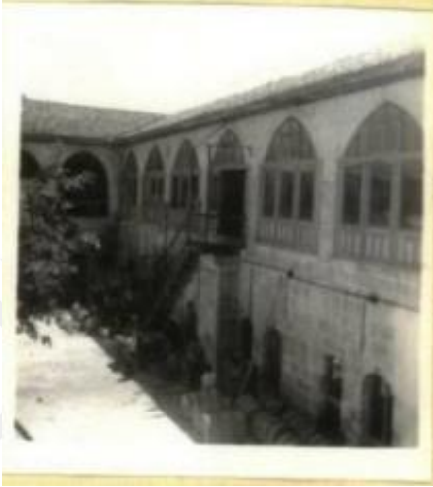
Şekil 4.118 Tuz Hanı'nın 1966 yılına ait avludan güney kanadı görünümü, revaklar kapalı durumda (KK arşivi, pdf no 45, eski eser fişi no 21)
