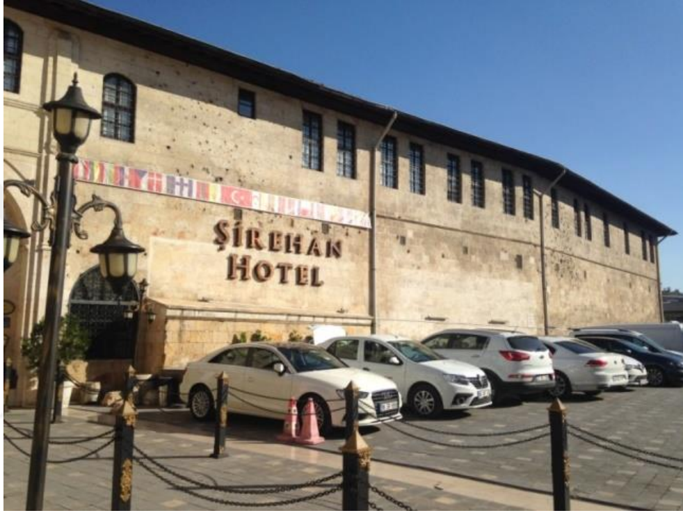
Şekil 4.211 Şirehan kuzey cephesi (Zincircioğlu, 2018)
