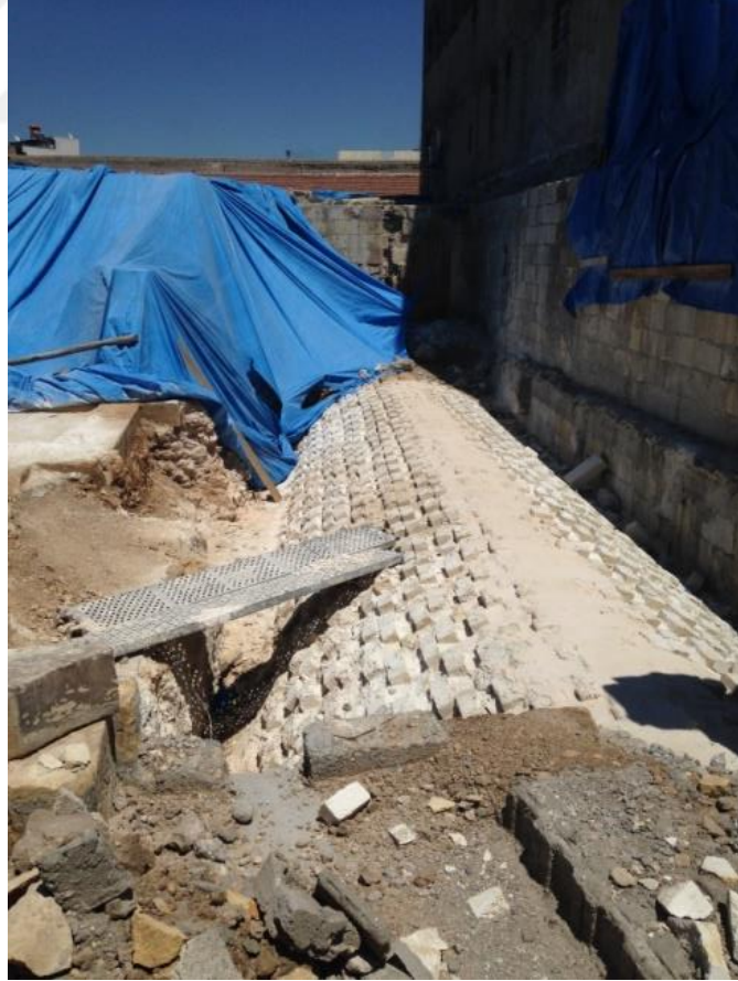
Şekil 4.95 Mecidiye Hanı devam eden restorasyon çalışmaları, ahır bölümünün tonozunun üst kattan görünümü (Zincircioğlu, 2018)
