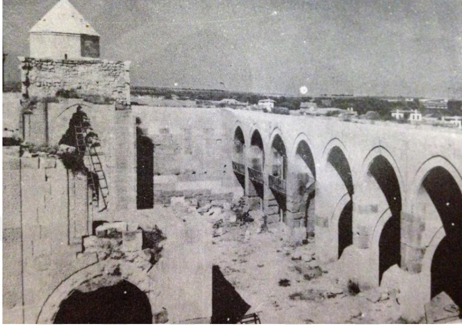
Şekil 2.7 Sultan Hanı avludaki revakların görünümü (İlter,1969)
