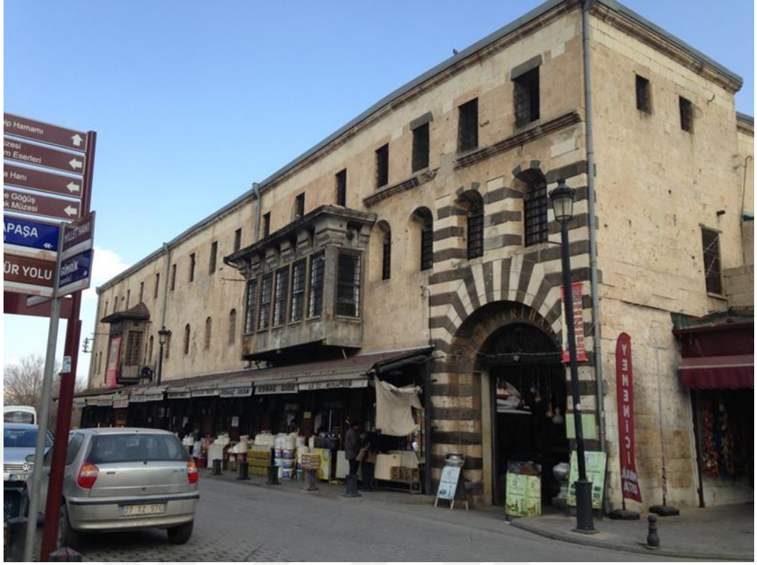
Şekil 4.253 Hanın güney tarafından cadde cephesi görünümü (Zincircioğlu, 2017)
