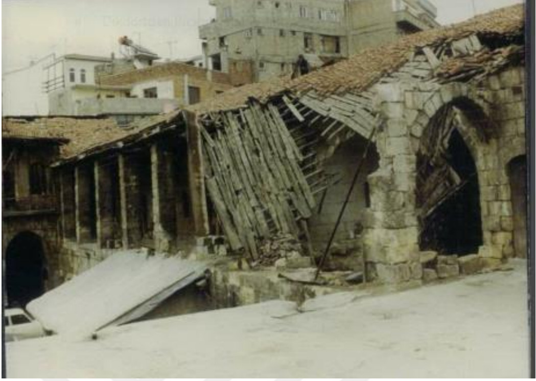
Şekil 4.3 Emirali Hanı doğu kanadında çökmelere ait 1992 tarihli fotoğraflar (Koruma kurulu arşiv raporları, pdf no 1023)
