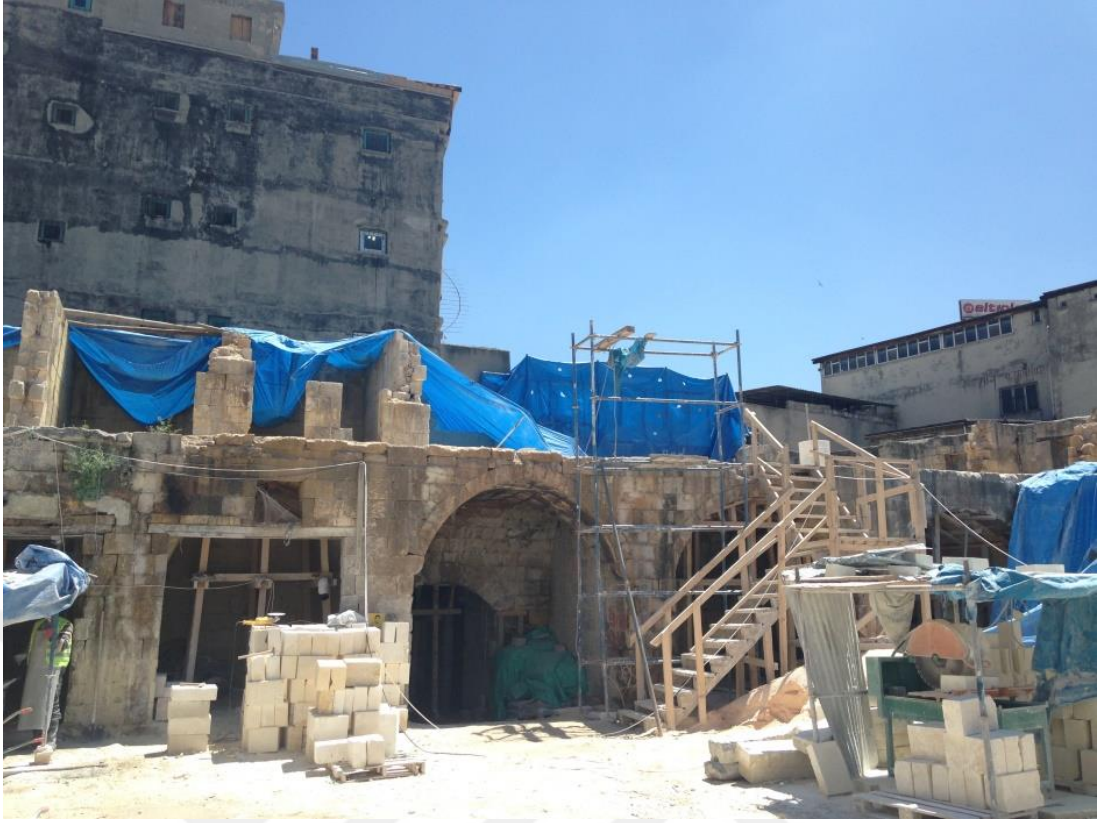
Şekil 4.97 Mecidiye Hanı, üzerindeki Şekil 4.91’de de görülen betonarme eklentilerden temizlenen ahır bölümü restorasyon çalışmaları (Zincircioğlu, 2018)
