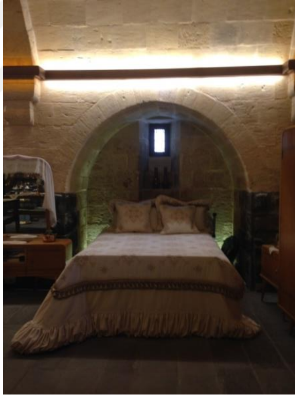
Şekil 4.164 Gümrük Hanı'nın günümüzde bir mağazaya dönüşen ahır bölümünde niş ve mazgal pencere (Zincircioğlu, 2018)
