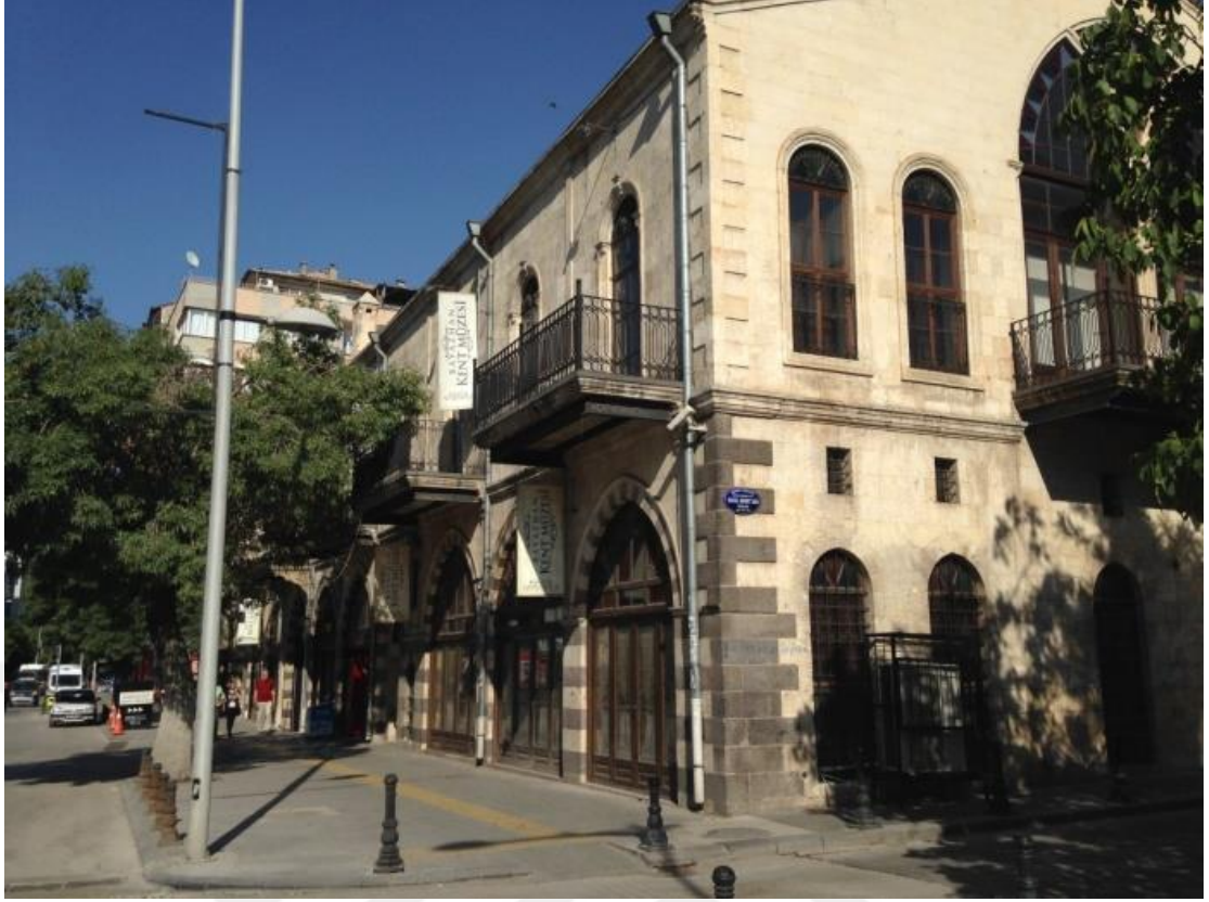
Şekil 4.348 Bayazhan kuzeybatı köşe cephe görünümü (Zincircioğlu, 2018)
