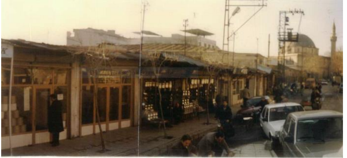
Şekil 4.12 Emirali Hanı caddeden güney cephesi görünümü, (Yetkin, 1997)
