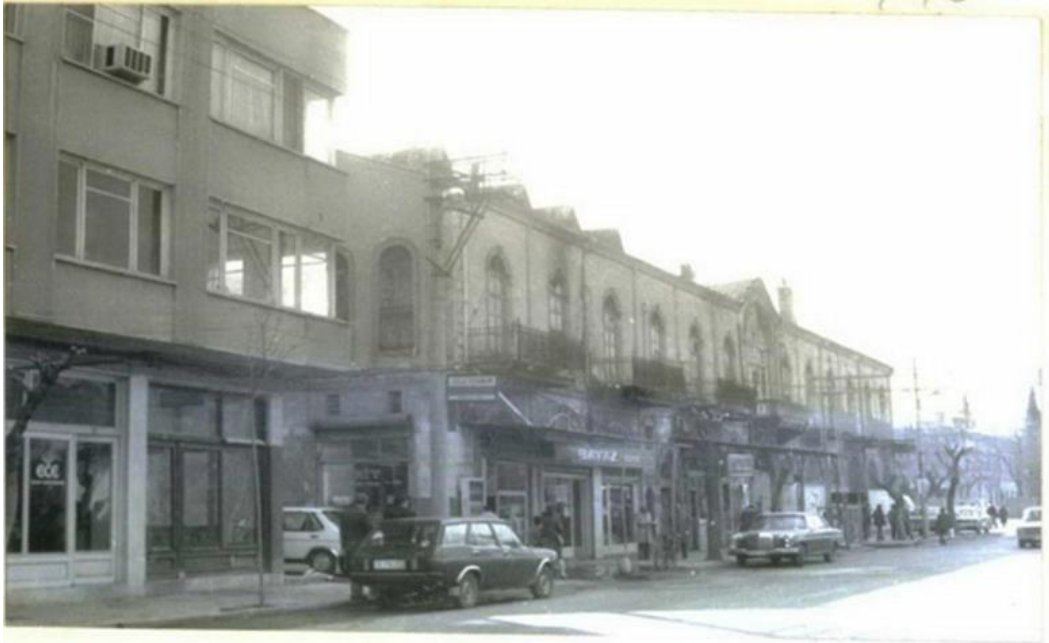
Şekil 4.333 Bayazhan giriş cephesi, Atatürk Bulvarı'ndan görünüm 1984 (Koruma Kurulu arşivi- pdf no: 11674)
