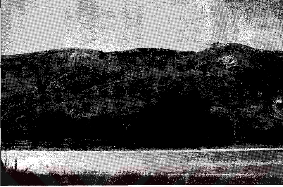
Foto:3. Gürün İlçe Merkezi'nin Batısında Kayseri Kara yolunun güneyinde Oluşmuş Heyelan Alanından Bir Görünüm
