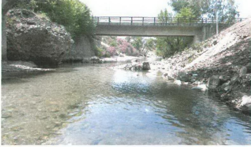
Şekil 3.8. Ören köprü örnekleme noktası
