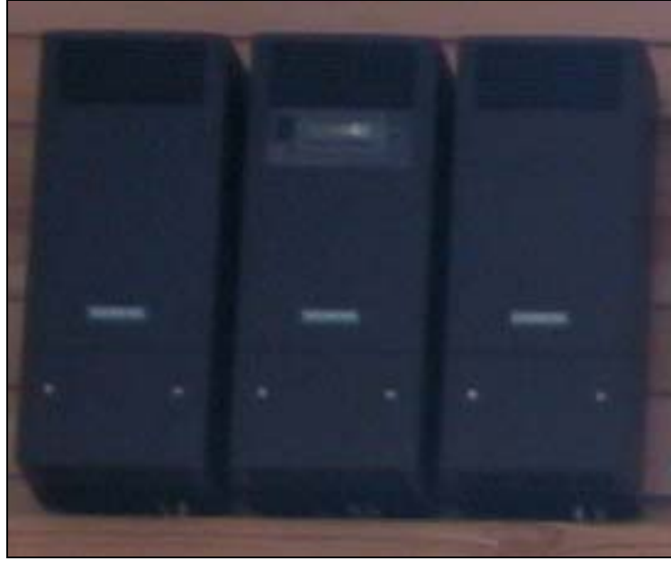
Şekil 3.6 Sitop solar 1500 Slave-Master-Slave üçlü invertör gurubu
