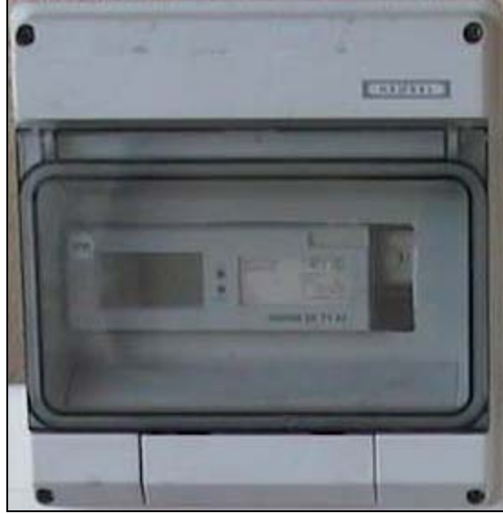
Şekil 3.12 DZ 4000 W tipi üç fazlı enerji sayacı
