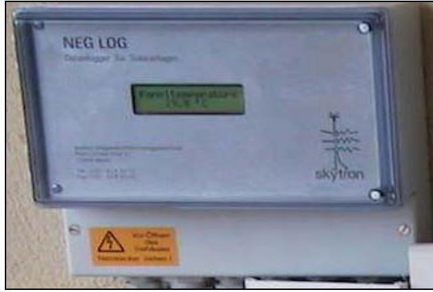
Şekil 3.10 NEG LOG data logger
