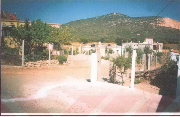
Foto 21: Germiyan Köyünde Son Yıllarda Yapılan Betonarme Konutlar
