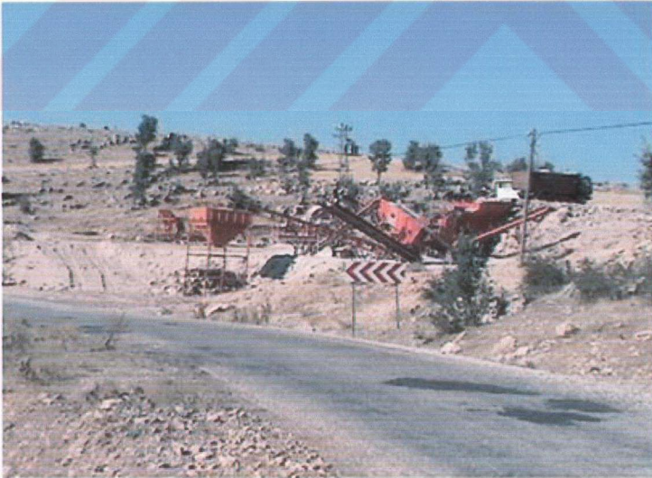
Foto 35: Gölbasi-Gaziantep Karayolunun Belören sapağında kurulmuş olan taş ocağı (Belören).
