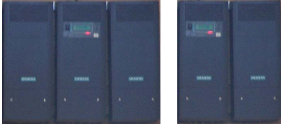
Şekil 3.5 Sitop solar 1500 Slave-Master-Slave üçlü ve ikili invertör gurubu
